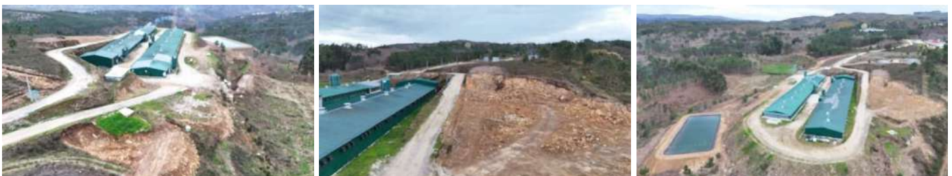
Foto 1: Situação atual da exploração (infraestruturas construídas).
