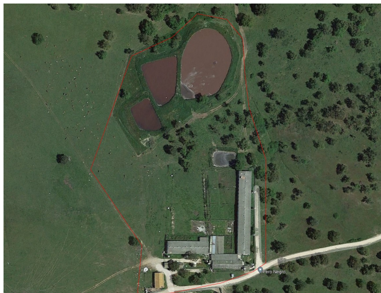
Figura 4 – Sistema de armazenamento de efluentes pecuários atual.
