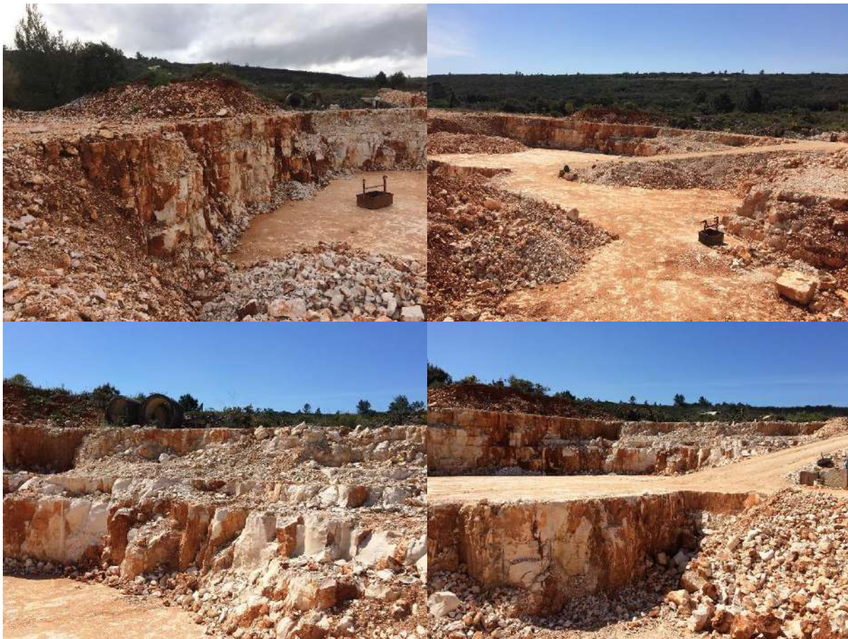
Fotos nº 2 – Aspectos das frentes de desmonte da pedreira “Poberais nº 4”.
