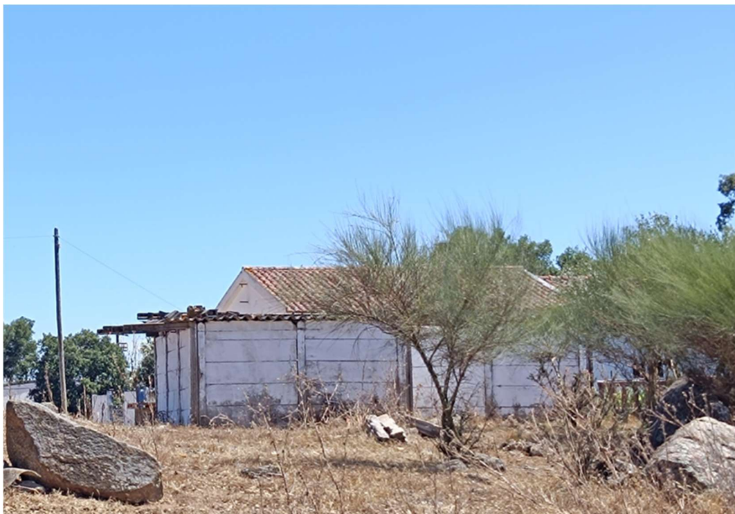
Figura III. 32 - Áreas edificadas na área de estudo.
