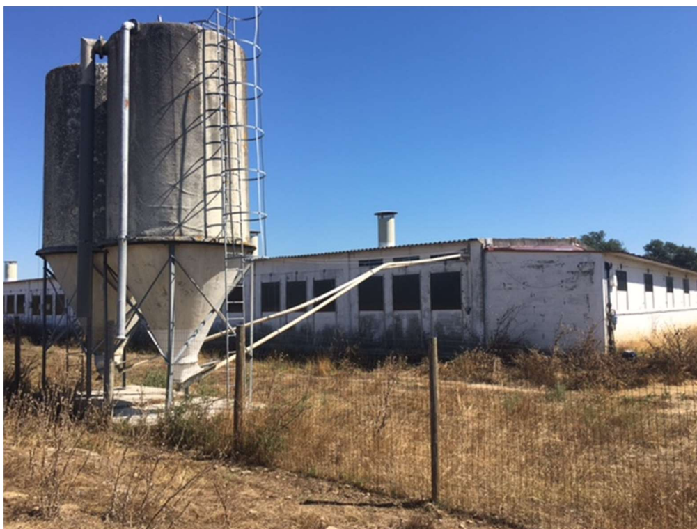
Figura II.2 - Silos de armazenamento de ração.
