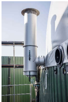
Figura 6. Válvula de segurança
