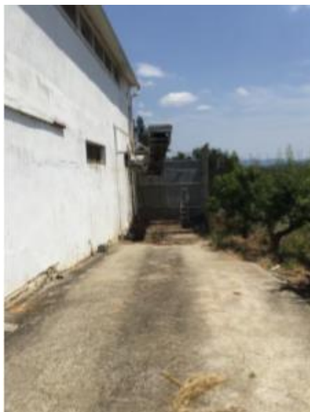
Figura 4: Local de carga de estrume em veículo com reboque para envio para o armazém de estrume
