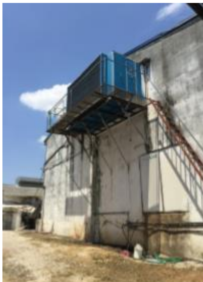
Figura 9: Sistema de pré-secagem do estrume no núcleo de Pinascos
