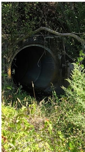
Figura 12 – Passagem Hidráulica localizada no alinhamento do talvegue da linha de água existente junto ao limite nascente da DBPT. Observação do lado sul da linha férrea.
