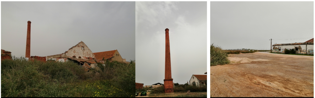
Figura 2: Vistas gerais sobre a área de intervenção / edifício e pátio interior / Aterro e zona norte da AI
