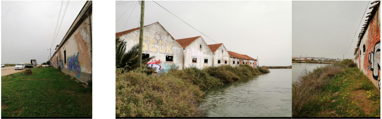
Figura 1: Vistas gerais sobre o edifício
