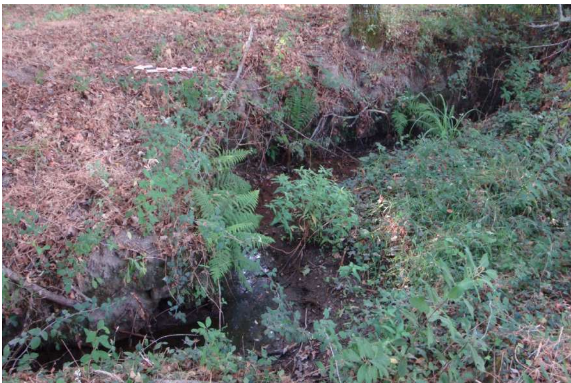
Figura 3 – Vista parcial da OP.1 (c).
