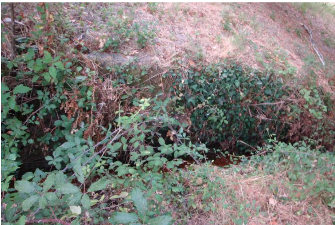
Figura 1 – Vista parcial da OP.1 (a).
