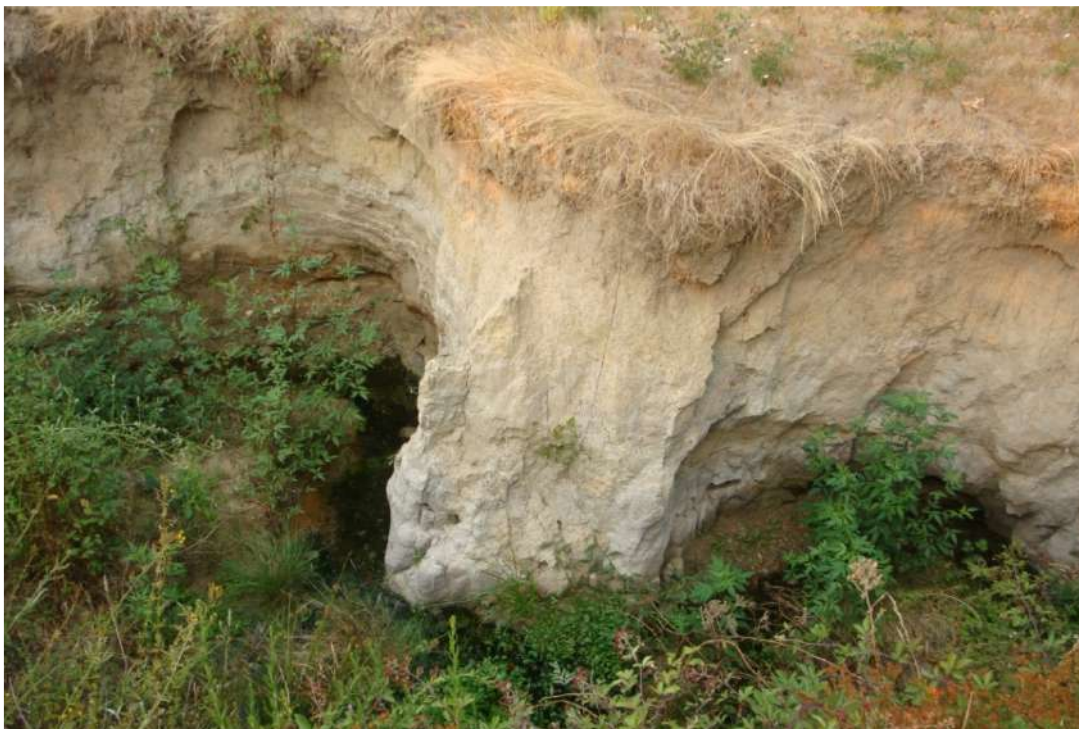
Figura 5 – Vista da área na qual se prevê a execução da ligação da rede de drenagem pluvial à linha de água.
