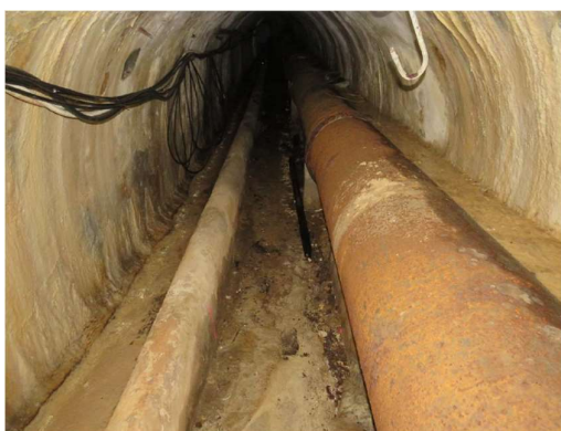
Figura 12 – Vista do interior da interferência 13
