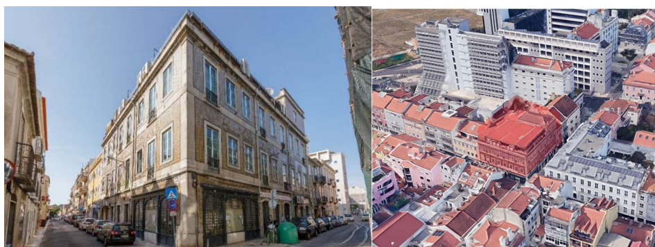
Figura 32 - Panificação Mecânica, fachada
