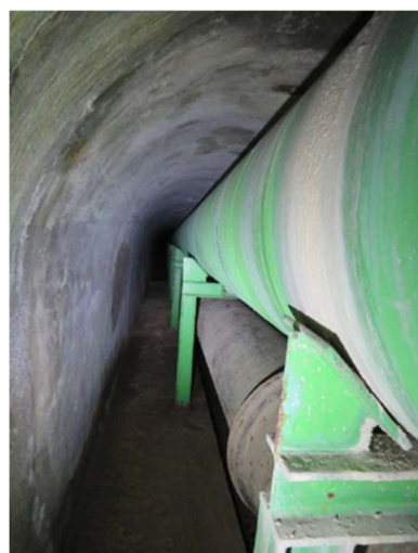
Figura 13 – Vista do interior da Interferência 54
