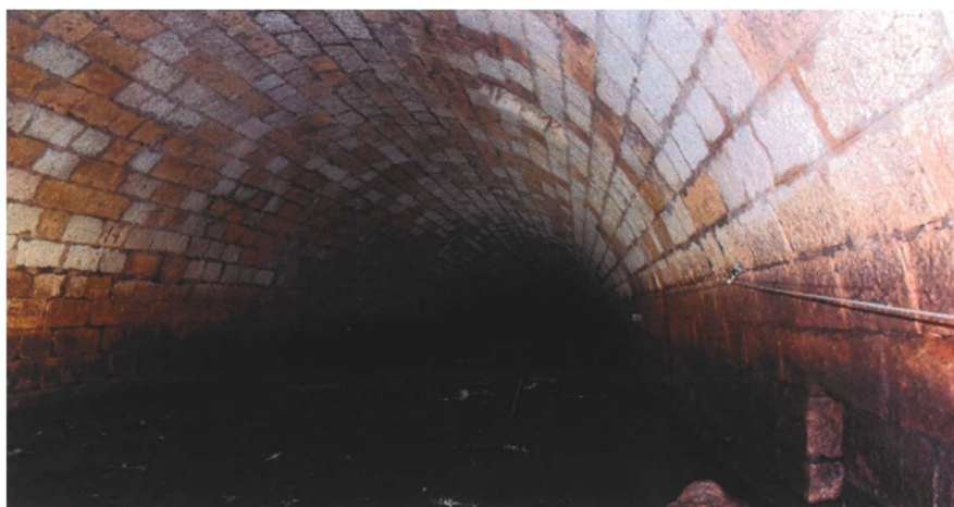
Figura 53 – Fotografia do interior do Caneiro de Alcântara (Secção nº5)
