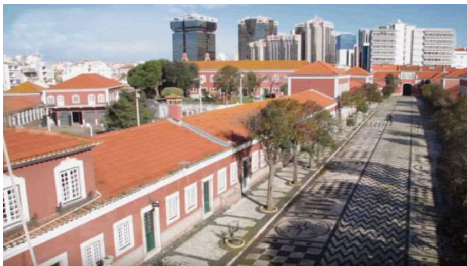
Figura 36 - Fachada lateral do Quartel de Campo de Ourique
