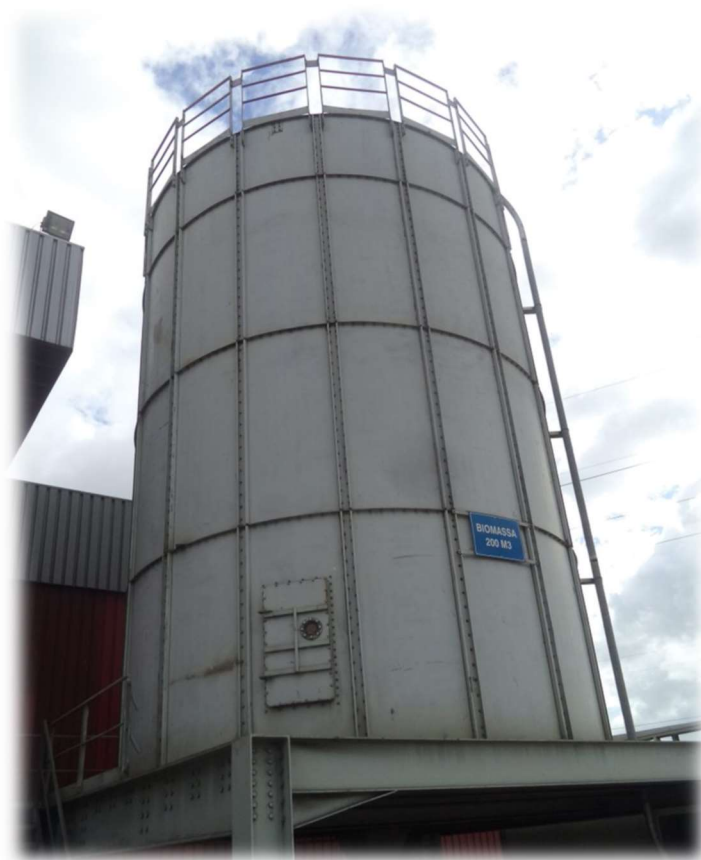
Figura 5 – Fotografia do silo de biomassa
