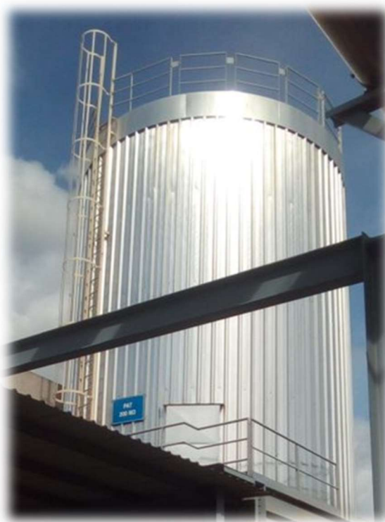
Figura 15 - Registo fotográfico da armazenagem de farinha animal a granel (silo exterior)
