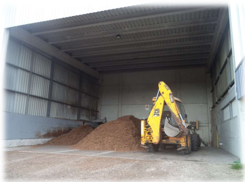
Figura 4 – Fotografia do parque de armazenagem de biomassa
