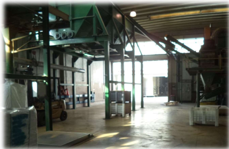
Figura 14 - Registo fotográfico da armazenagem de farinha animal a granel (tolvas)
