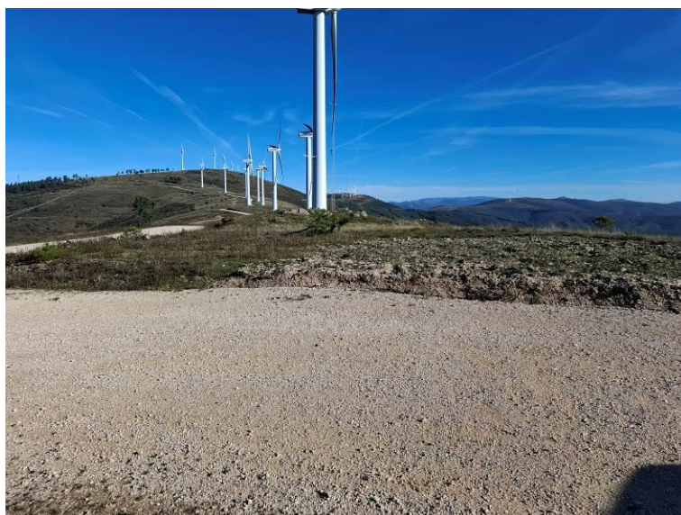
Foto 7 – Zona de constituição da plataforma do aerogerador n.º 2
