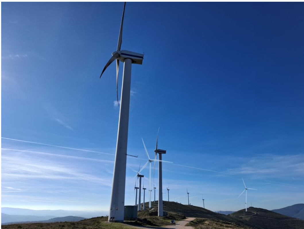
Foto 8 – Vista para sudoeste a partir do aerogerador n.º 12
