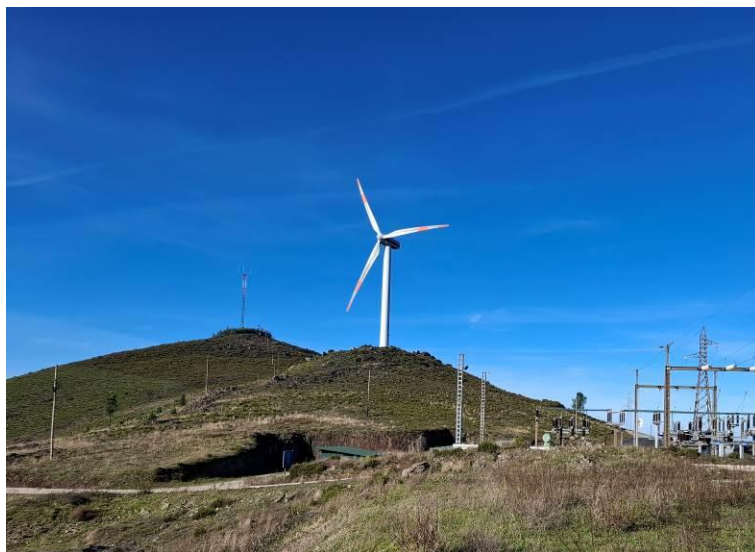
Foto 4 – Vista para o aerogerador n.º 1 de nascente
