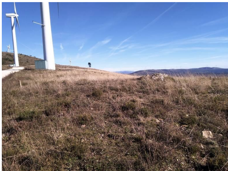
Foto 3 – Localização do Estaleiro n.º 2
