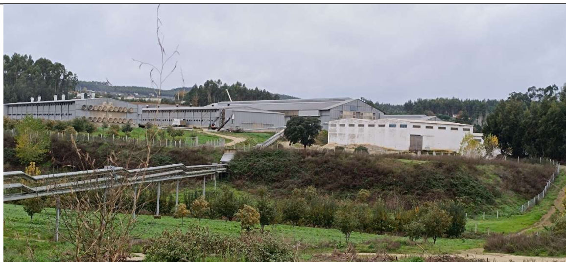
Figura 7.22 – Vistas de outras áreas de usos industriais (instalação avícola da Cabrala) localizados na proximidade da instalação avícola em estudo.
