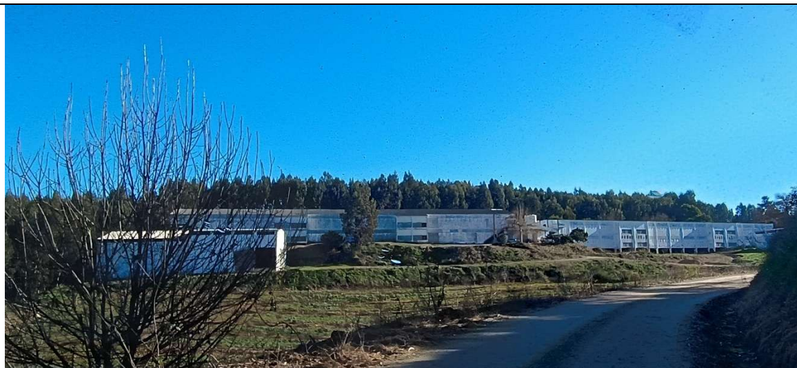
Figura 7.34– Vistas de áreas de usos industriais referentes á instalação avícola em estudo
