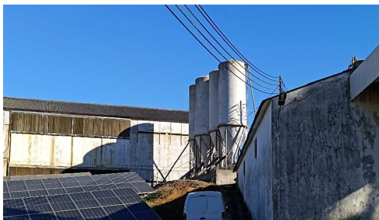
Figura 6.4 – Vista dos Silos
