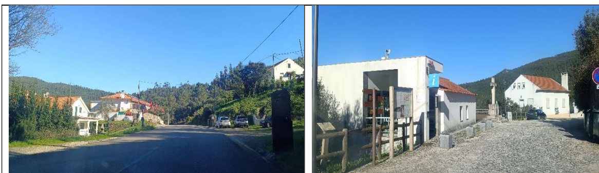
Figura 7.35 e Figura 7.36– Vistas sobre a ocupação habitacional
