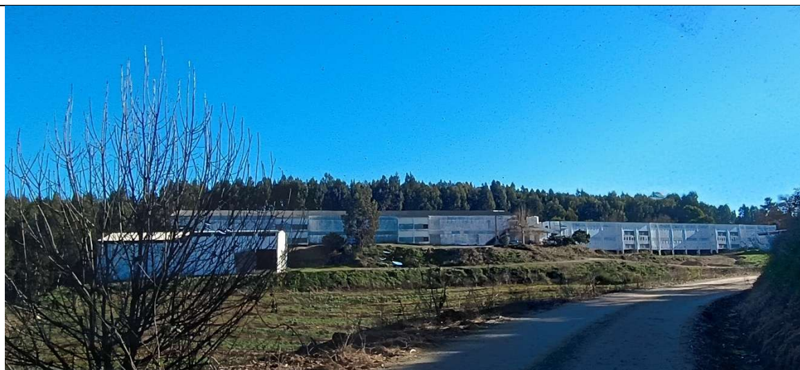
Figura 7.21 – Vistas de áreas de usos industriais referentes á instalação avícola em estudo
