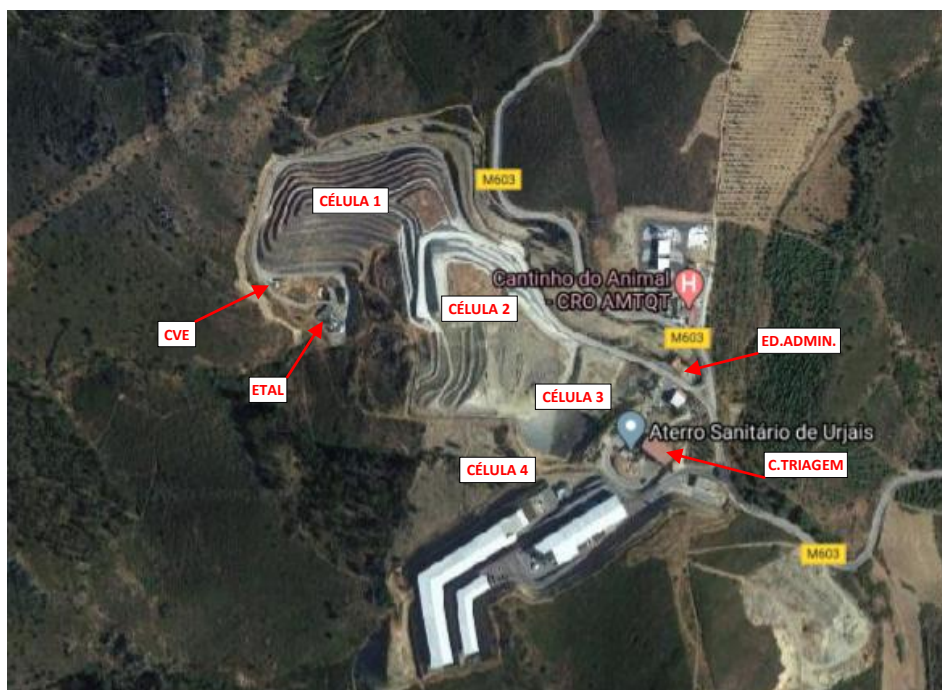
FOTOGRAFIA 1 vista aérea do aterro sanitário de Urjaís (fonte: googlemaps)
