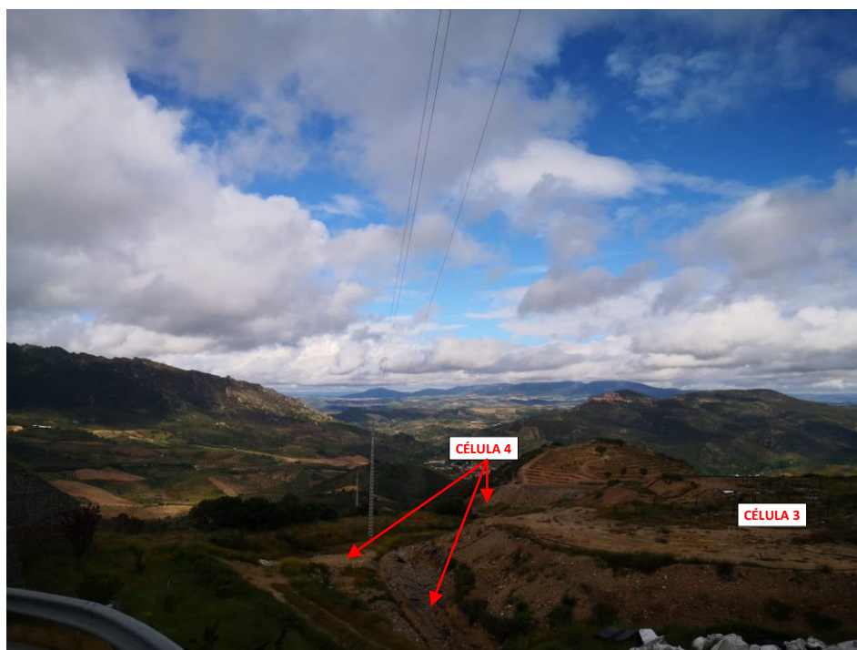
FOTOGRAFIA 2 vista geral do aterro
