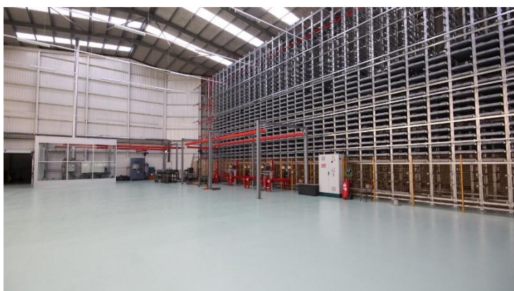
Figura 18: Novo espaço de armazenamento (espaço da antiga Lacagem Vertical I).
