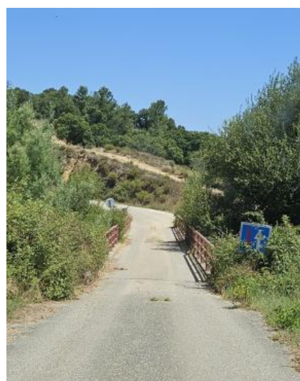
Figura 3.25 – Registo Fotográfico (acesso existente) P13
