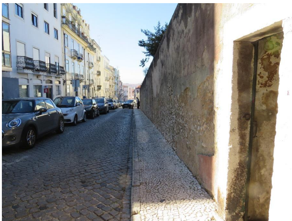
Foto 1 – Vista envolvente à zona superior do Aqueduto vistoriado
