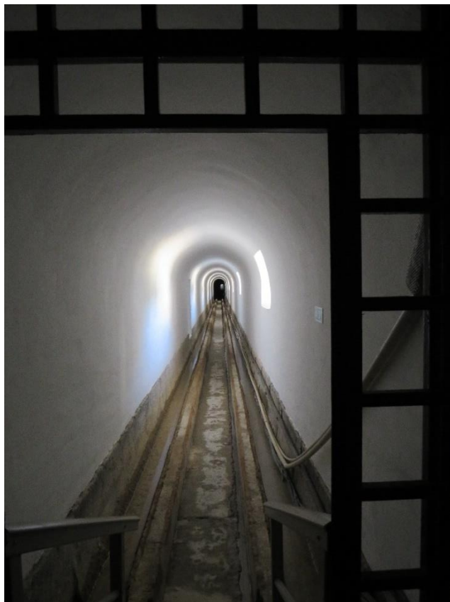
Foto 2 – Vista do interior do aqueduto de E para W pela entrada junto da esquina SE da Célula 1 do Reservatório do Arco
