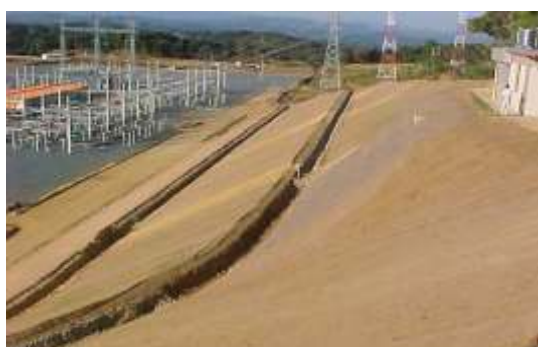
Taludes já protegidos com biomantas antierosivas
