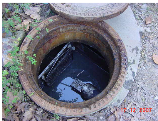
Figura 2 - Pormenor separador hidrocarbonetos da pista lavagem viaturas.
