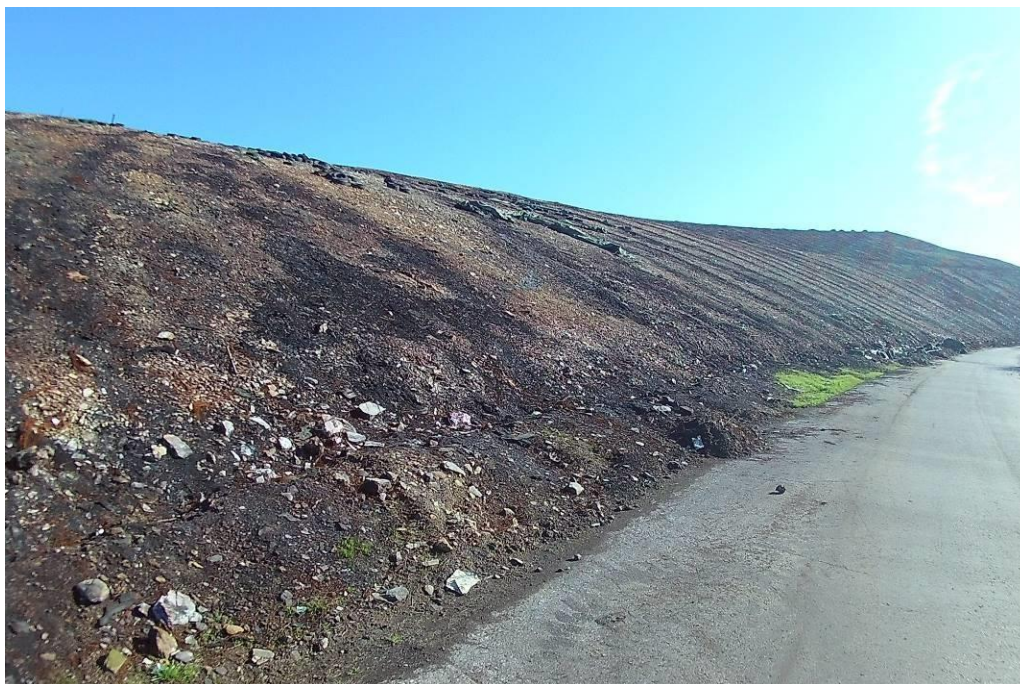
Figura 2 – Fotografia do aterro da AMRPB, vertente Oeste, vista inferior (Novembro, 2017)
