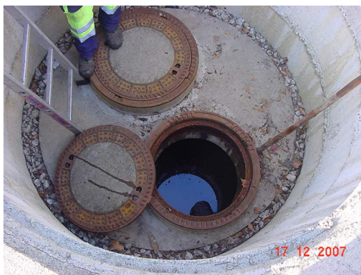
Figura 3 – Separador hidrocarbonetos – águas zona oficina
