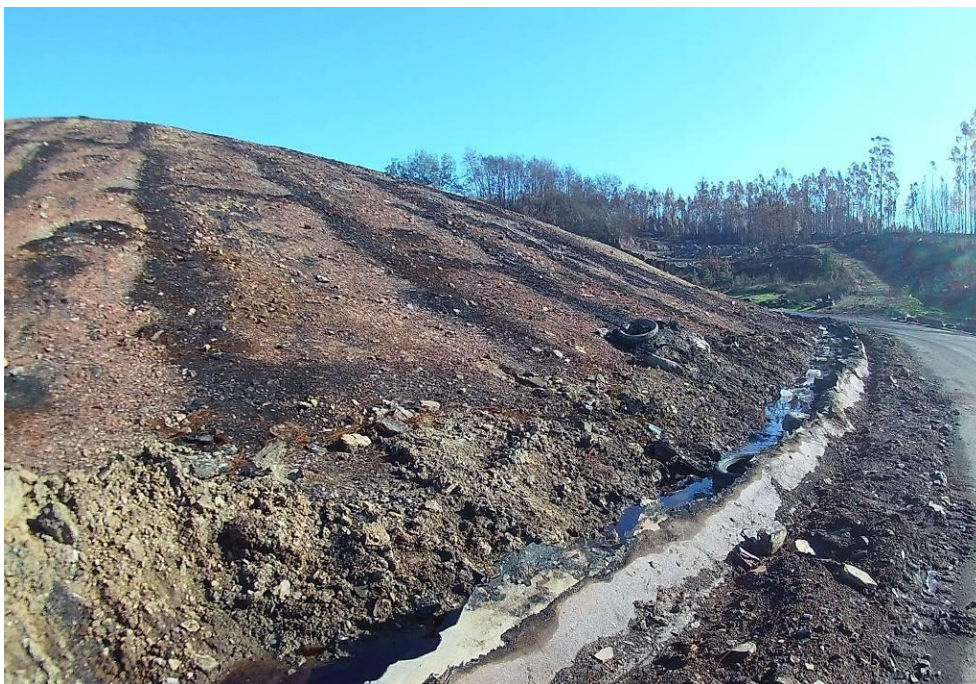
Figura 4 – Fotografia do aterro da AMRPB, vertente Sul (Novembro, 2017)
