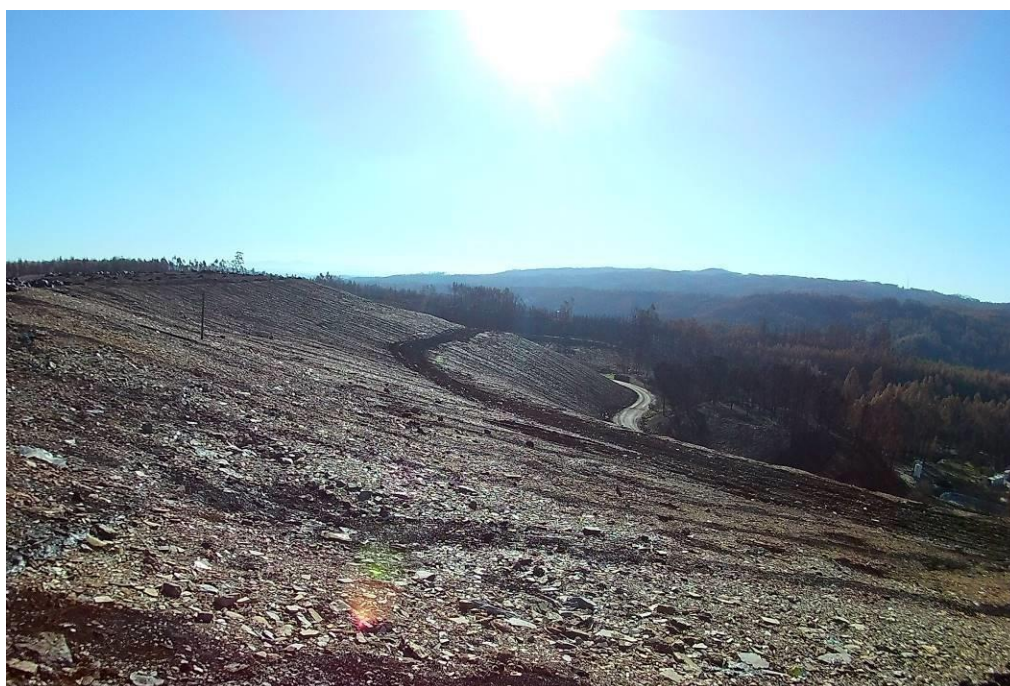
Figura 3 – Fotografia do aterro da AMRPB, vertente Oeste, vista superior (Novembro, 2017)
