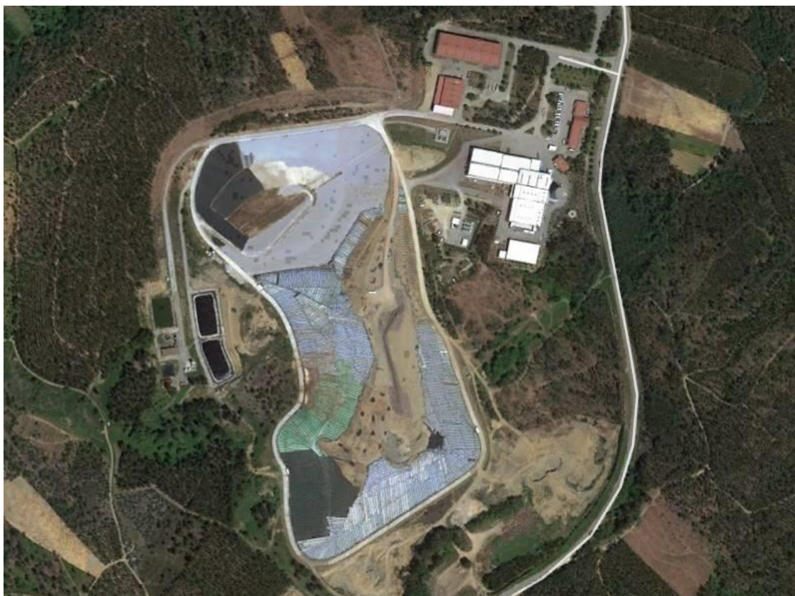
Figura 1 – Fotografia aérea do aterro da AMRPB (2013)
