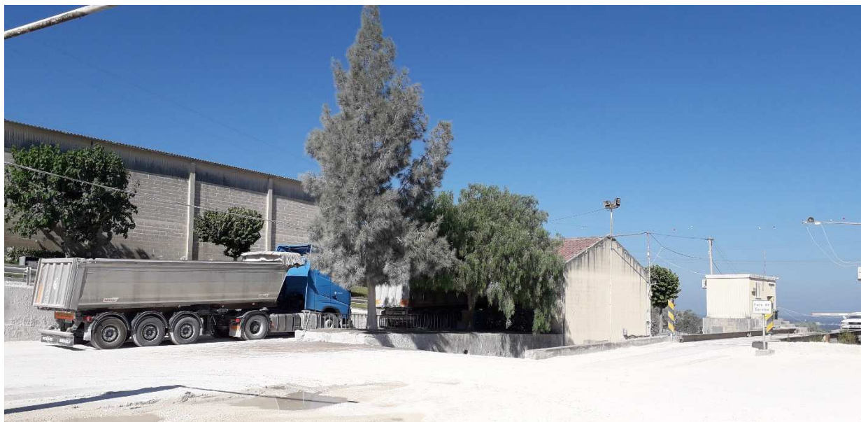
Fotografia 5EA – Vista da área verde junto ao edifício – báscula/escritório.
