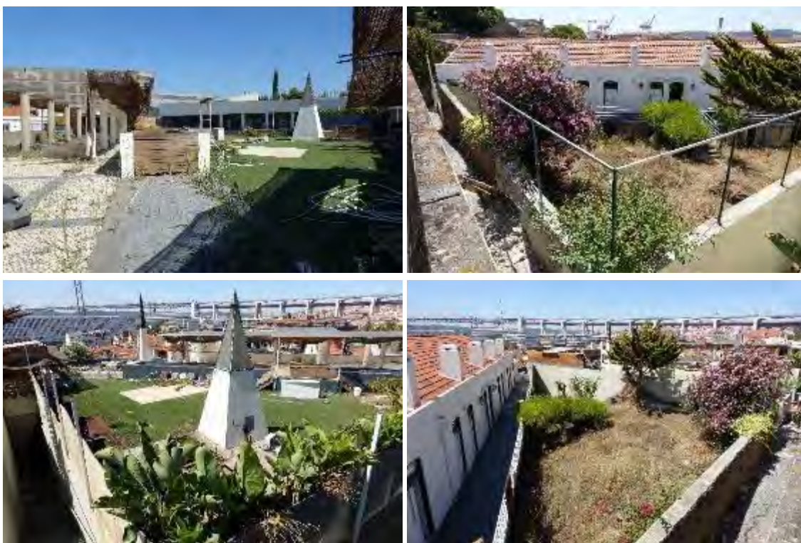
Figura 294, 295, 296 e 297 – Pormenor das áreas de implantação de estaleiro no Baluarte do Livramento.
