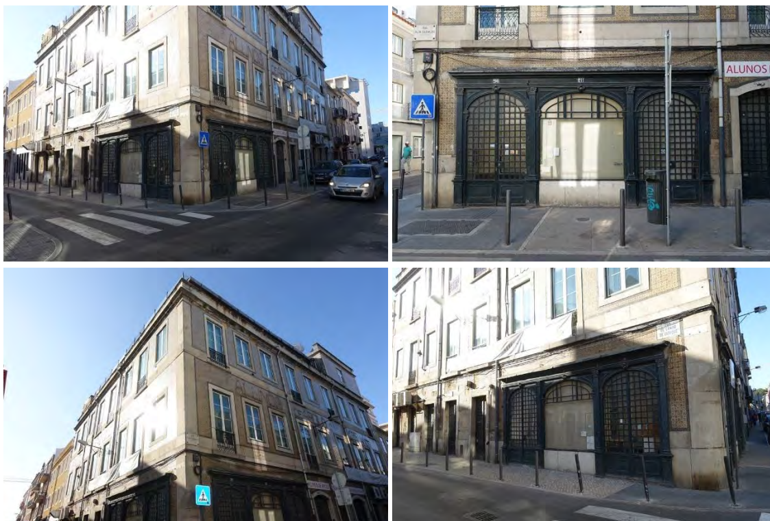
Figura 70 e 71 - Edifício e Estabelecimento da Panificação Mecânica (EP 40) (Fotografia de Nuno Pires, agosto de 2024).
