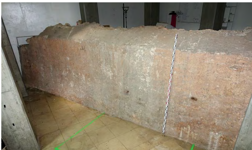
Figura 139 – Troço da muralha Filipina subsistente no interior do edifício contemporâneo.
