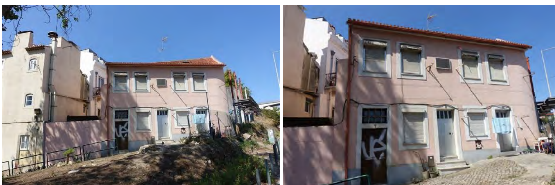
Figura 226 e 227 – A (I 409): edifício que em meados do século XIX já se encontrava edificado e cuja demolição está prevista (fotografias de Nuno Pires, agosto de 2024).
