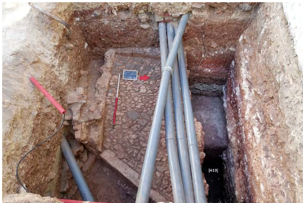
Figura 148 – Plano final da sondagem 4 após avanço da escavação pela unidade [419].
