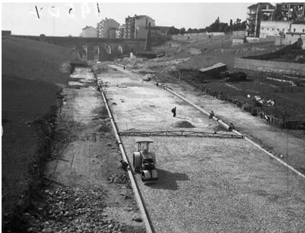
Figura 111 – Abertura da Avenida Infante Santo, fotografia de Judah Benoliel, 1949 (PT/AMLSB/CMLSBAH/PCSP/004/JBN/004153).
