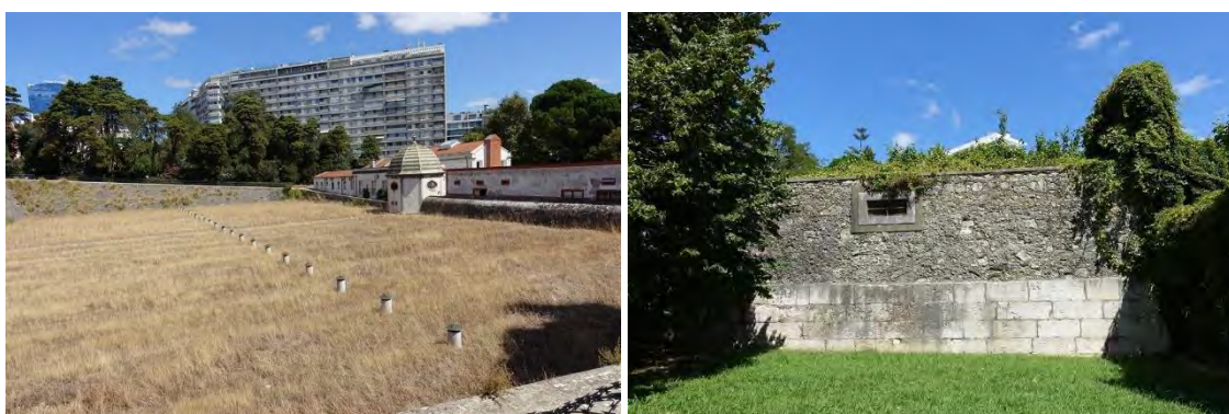
Figura 56 e 57 - Reservatório das Amoreiras (EP 118) (Fotografia de Nuno Pires, agosto de 2024).
