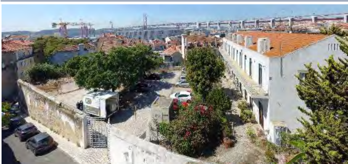
Figura 293 – Vista geral da área de estaleiro no Baluarte do Livramento.
