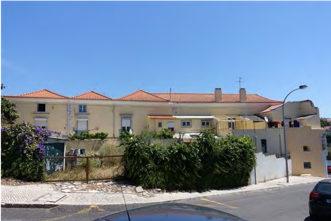
Figura 249 – Vista geral do Palácio Fiúza, à direita o corpo cuja demolição está prevista.
