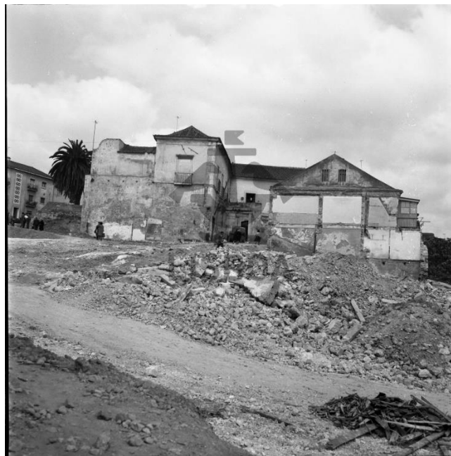
Figura 244 – Demolições parciais do Palácio Fiúza nos anos 60 do século XX (AML).
