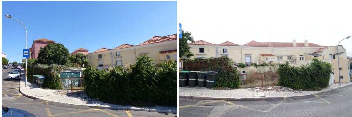
Figura 234 e 235 – Vista geral da área M (I419, I420 e I421) a norte do acesso à Ponte 25 de Abril, na Rua Quinta do Jacinto, junto ao Palácio Fiúza (em segundo plano).
