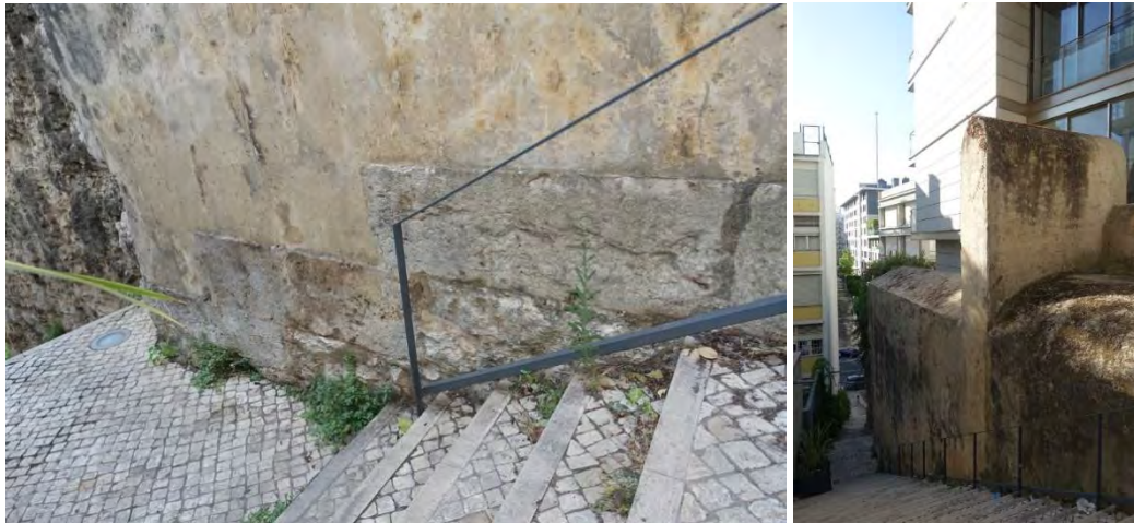
Figura 144 e 145 – EP 030g vestígios do aqueduto e troço restaurado nas escadas que ligam a Av. Infante santo à Calçada das Necessidades (fotografias de Nuno Pires, agosto de 2024).
