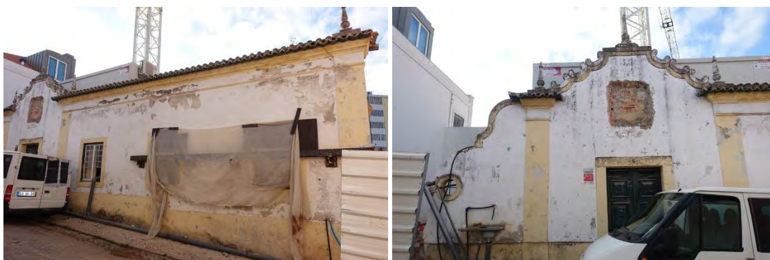
Figura 148, 149 e 150 – EP 082, edifício em obras (fotografias de Nuno Pires, agosto de 2024).
