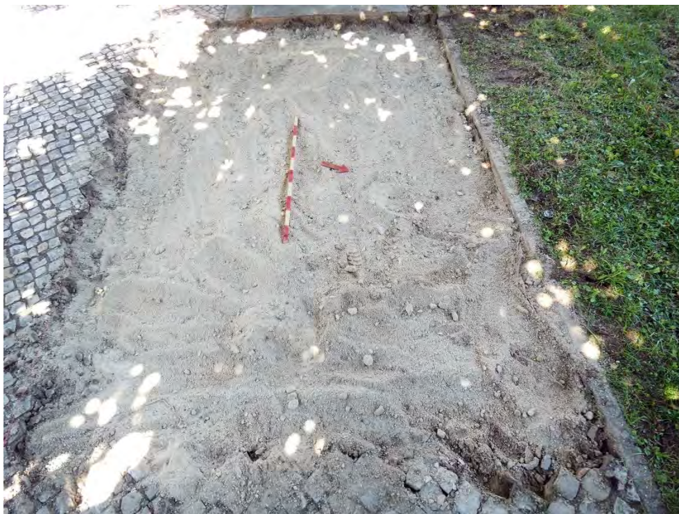
Figura 333 – Camada de tout-venant de assentamento da calçada.
