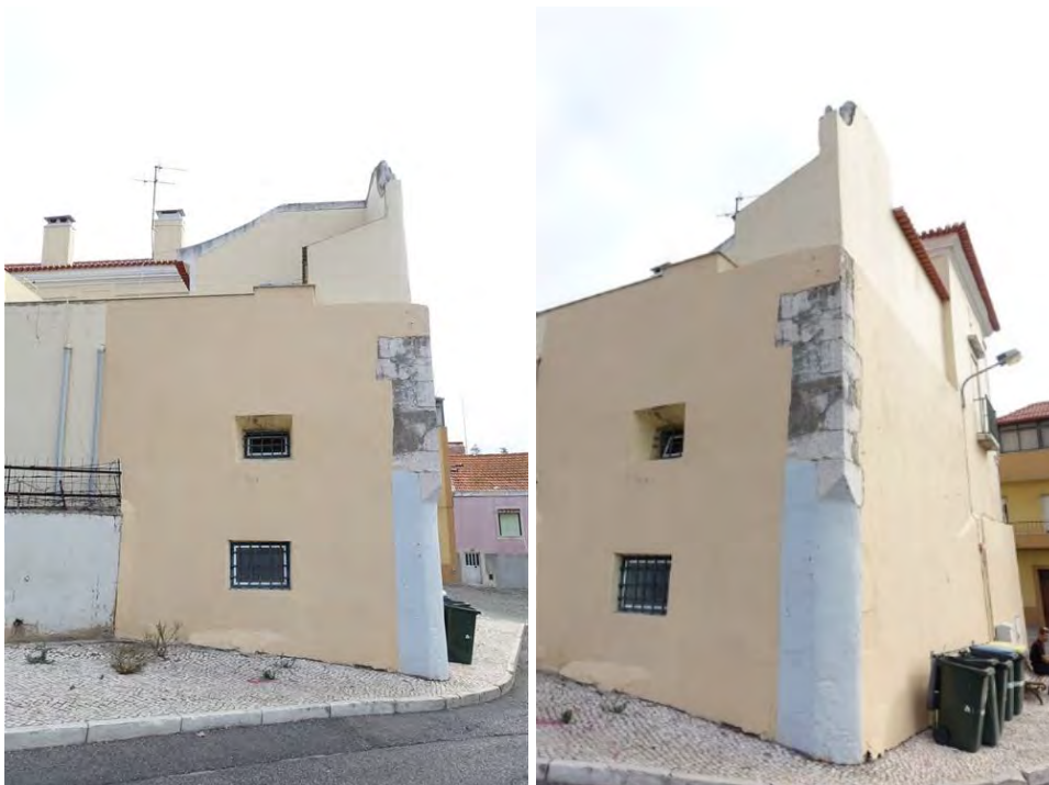
Figura 250 – Palácio Fiúza: corpo cuja demolição está prevista.
