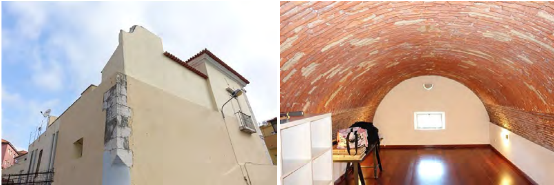
Figura 251 e 252 – Palácio Fiúza: demolições previstas. À direita pormenor do corpo a demolir, com teto abobadado.
