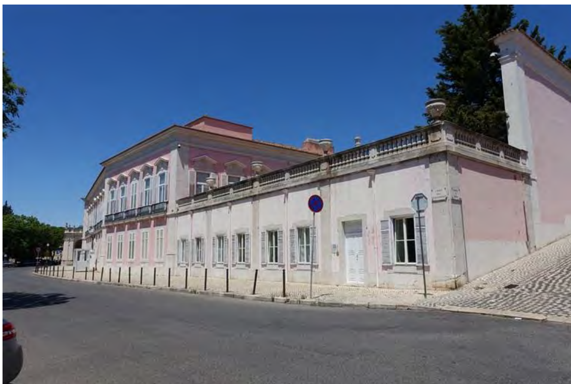
Figura 163 – Palácio das Necessidades (EP026): ângulo nordeste sob o qual irá passar o túnel do metro (fotografia de Nuno Pires, agosto de 2024), designado na planta de 1844 como “Pateo do Imperador”.
