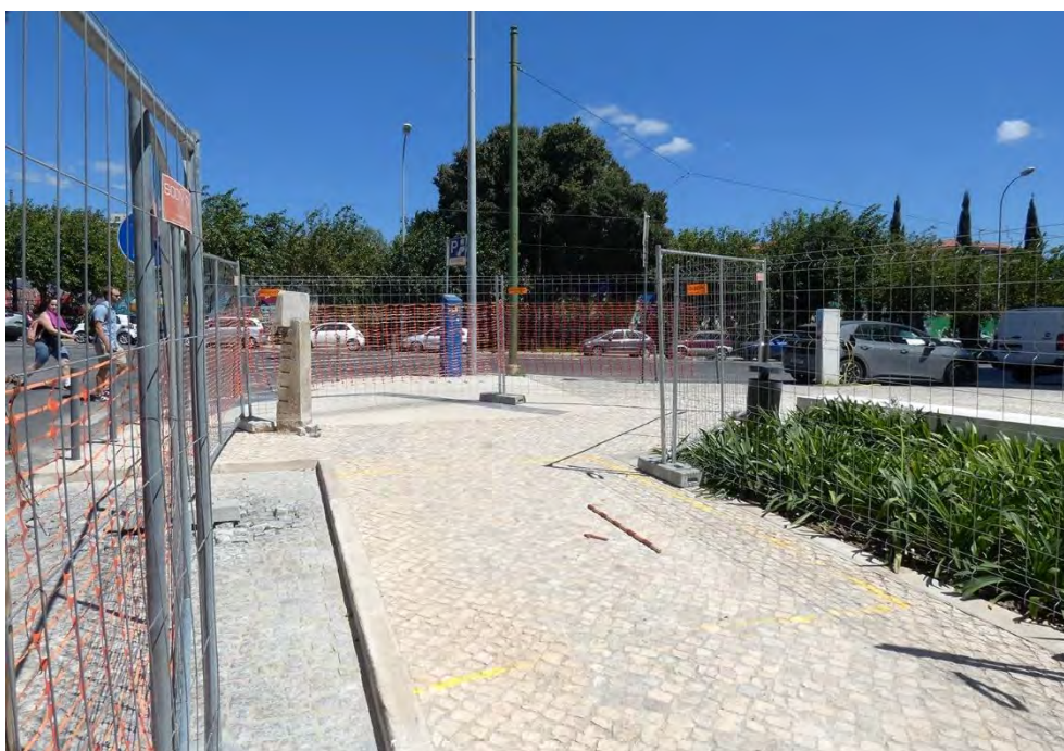
Figura 328 – Aspeto geral do local de implantação da sondagem 2, observando-se a calçada [200].
