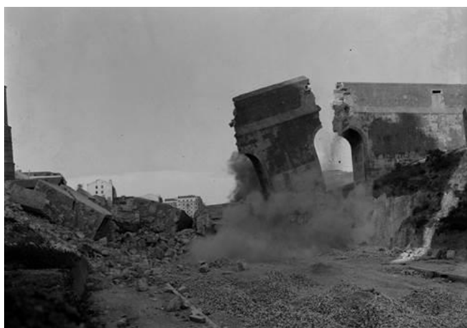
Figura 155 – Demolição do troço do aqueduto das Águas Livres na zona das terras de Santana, para a abertura da avenida Infante Santo. Fotografia de Júlio Marques da Costa, de 09-05-1949 (PT/AMLSB/CMLSBHAH/PCSP/004/FMC/000006)
