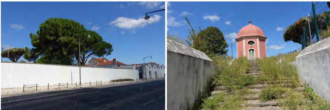
Figura 18 e 19 – Reservatório do Pombal (fotografia de Nuno Pires, agosto de 2014).
