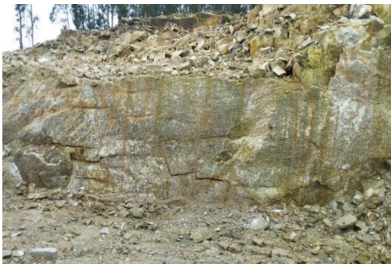
Figura 29 – Observação das principais famílias de diáclases com fraturação F4-F3 e grau de alteração W4-W3, presentes no substrato rochoso do talude a noroeste da área: estação geológica #2.
