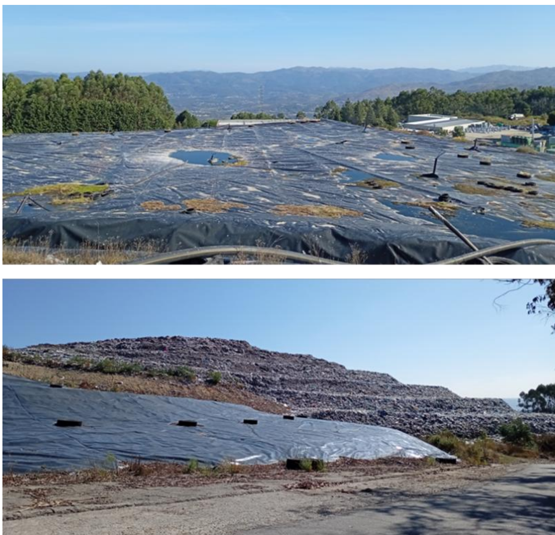
Figura 138 - Panorâmicas das células do aterro existente – em cima, plataforma da célula 1; em baixo, taludes das células 1 (à esquerda) e célula 2 (à direita, ao fundo).
