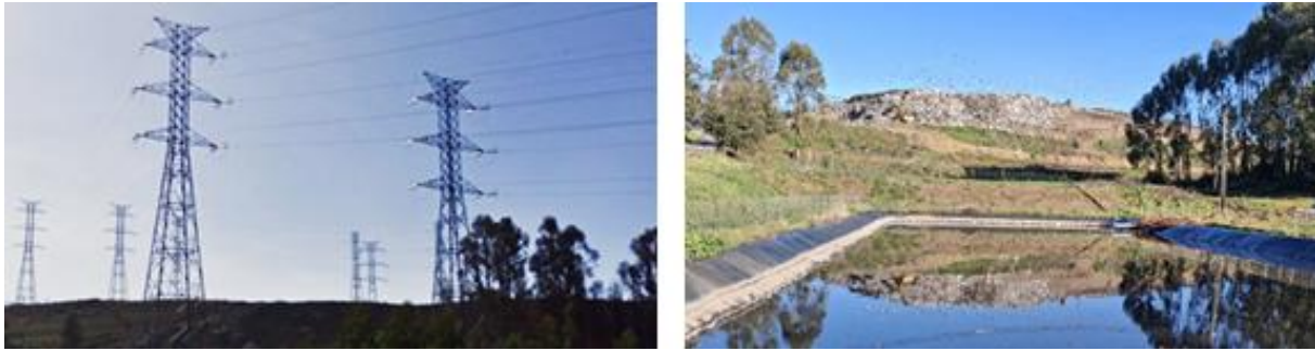
Figura 246 – Estruturas de transporte de eletricidade (esq.) e aterro e lagoa de lixiviados (dta.).
