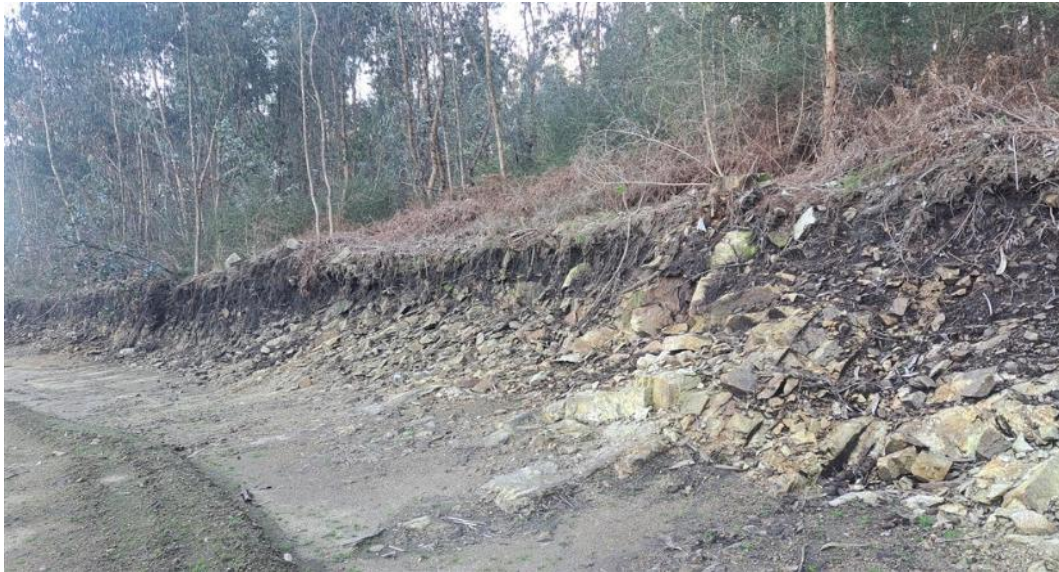
Figura 176 - Extremo oeste da área do projeto - talude dos desaterros.
