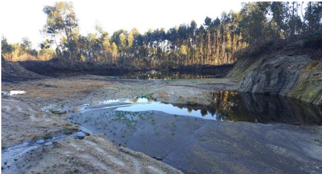
Figura 180 - Vista geral da área do projeto, ao centro, desaterrada.
