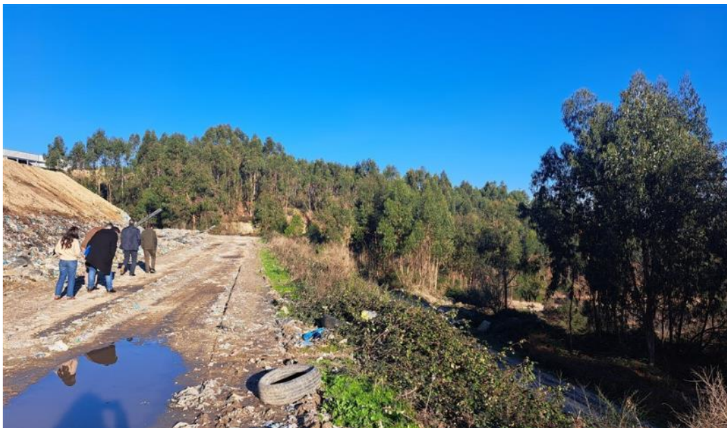
Figura 173 - Caminho de acesso à área do alargamento do aterro, a sul (à direita).
