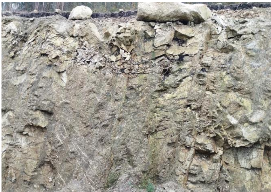
Figura 31 – Observação de talude rochoso granítico, medianamente alterado W3 a muito alterado W4 e muito fraturado F4, com evidência de movimentos de dobramento e preenchimento argiloso: estação geológica #4.
