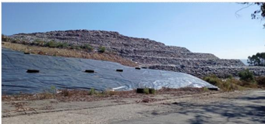
Figura 185 - Panorâmica em cima (a norte) e em baixo (a sul) do local destinado à reengenharia do aterro.
