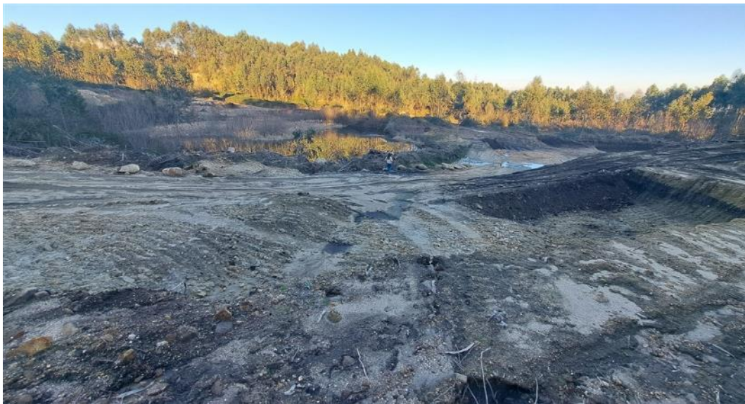
Figura 178 - Vista geral da área do projeto, vista de oeste para este, desaterrada.
