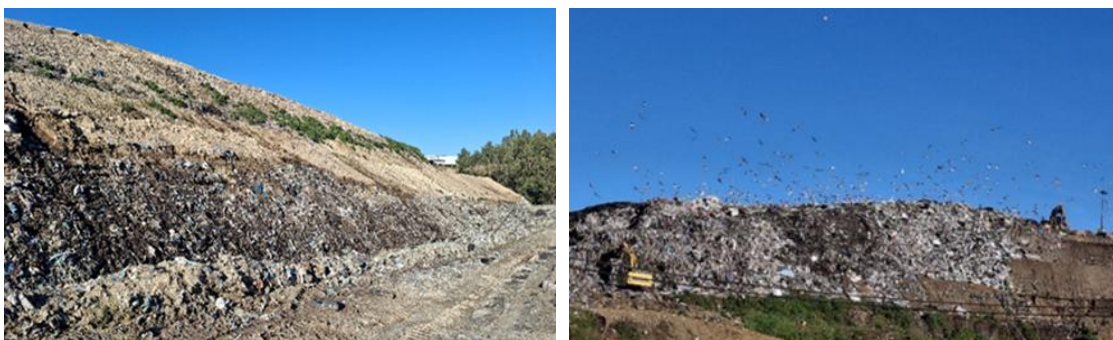
Figura 110 – Área de reengenharia – talude sul do aterro em exploração, à esquerda, e evidência da atratividade exercida na avifauna, à direita.
