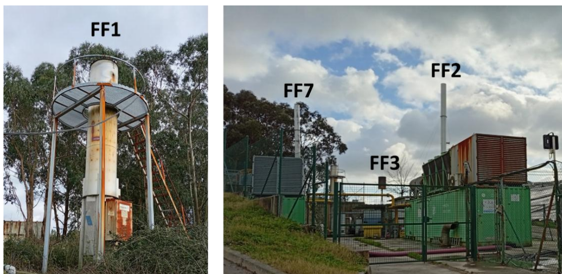
Figura 83 – Fotografia das fontes fixas FF1, FF2, FF3 e FF7.
