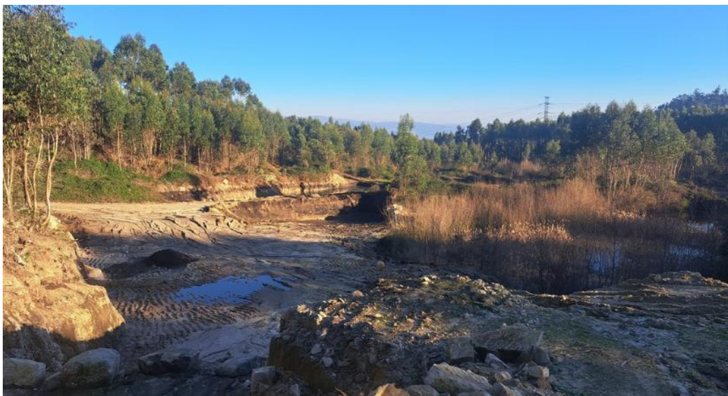
Figura 175 - Vista da área do projeto, de norte para sul, desaterrada.
