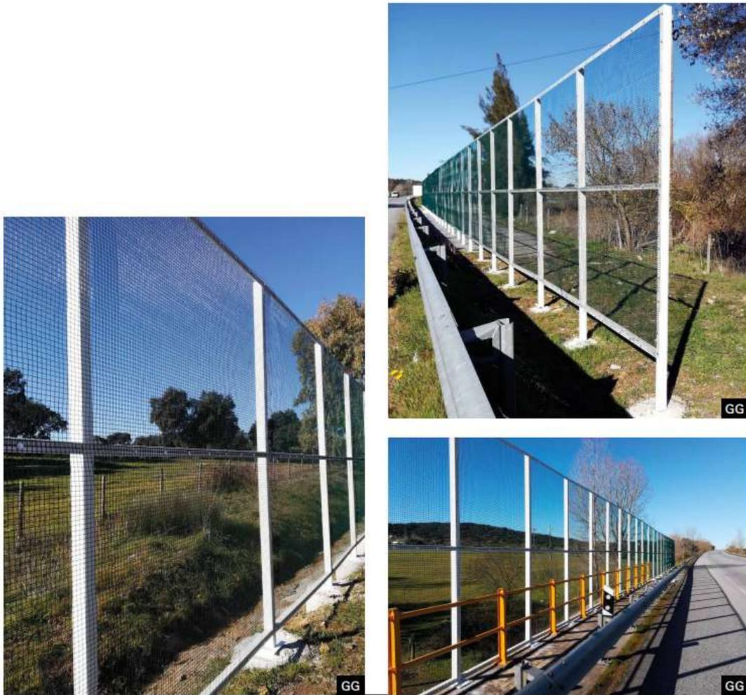
Figura 8.1 – Exemplos de aplicação de barreiras em rede para elevação de voo (adaptado de Garcia *et al.*, 2021).
