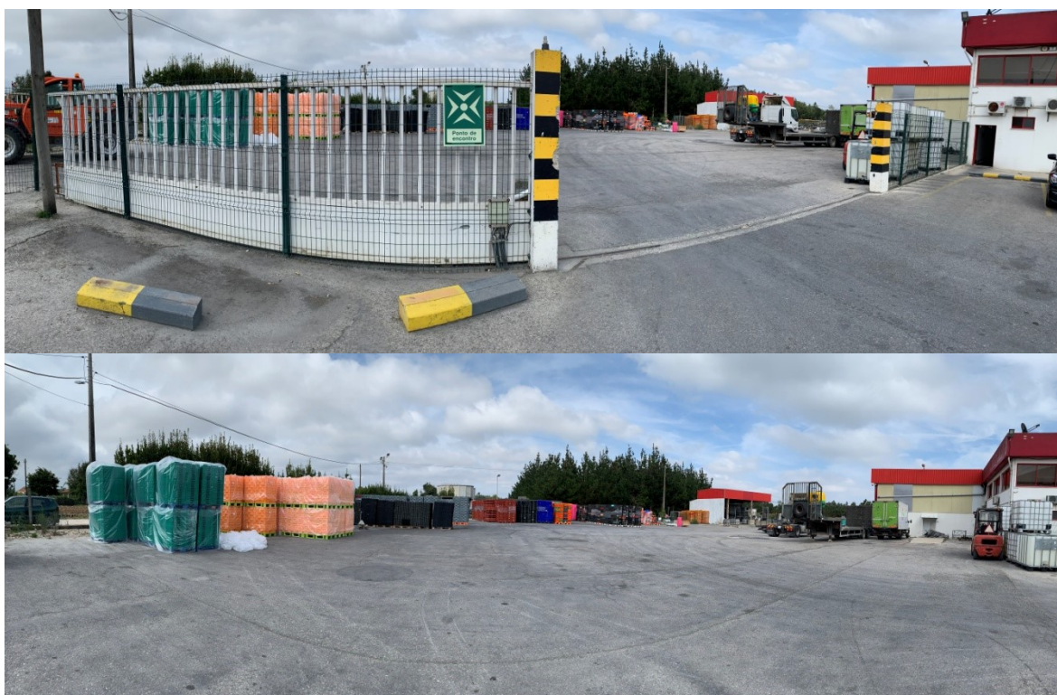
FIGURA 4. FOTOGRAFIAS DA ÁREA A INTERVENCIONAR NA AMPLIAÇÃO DO CAIS DE FRANGO VIVO
