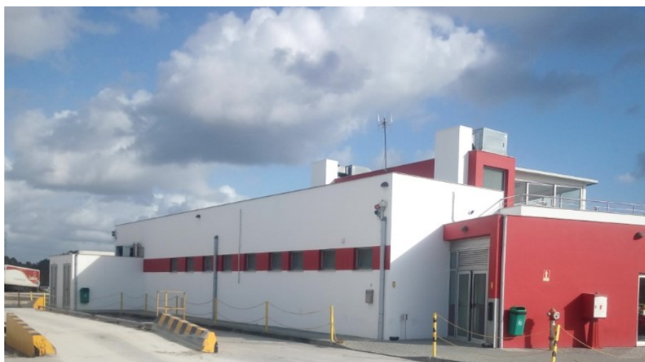
FIGURA 2. REFEITÓRIO DA UNIDADE INDUSTRIAL
