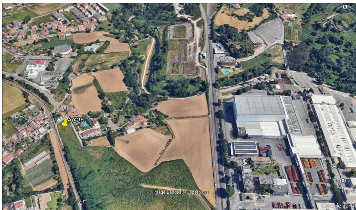
Figura 1 – Localização Geográfica dos furos de Captação AC35.
