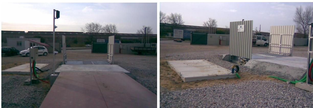
Figura 2 - Exemplo de sistema de lavagem de rodados
