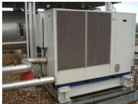
Para efeitos de determinação dos consumos e do desempenho deste equipamento foram monitorizadas as temperaturas do fluido (água com anticongelante) à entrada e saída do Chiller assim como o respetivo caudal e a potência elétrica absorvida pelo equipamento.
