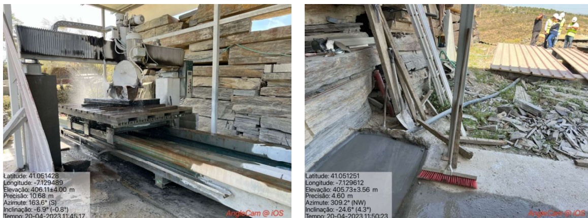
Figura 177: Fotografia da máquina de corte e dos tanques de decantação existentes associados ao sistema de recirculação de águas do corte.
