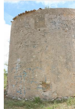
03 – Oc. 1, vista de oeste
