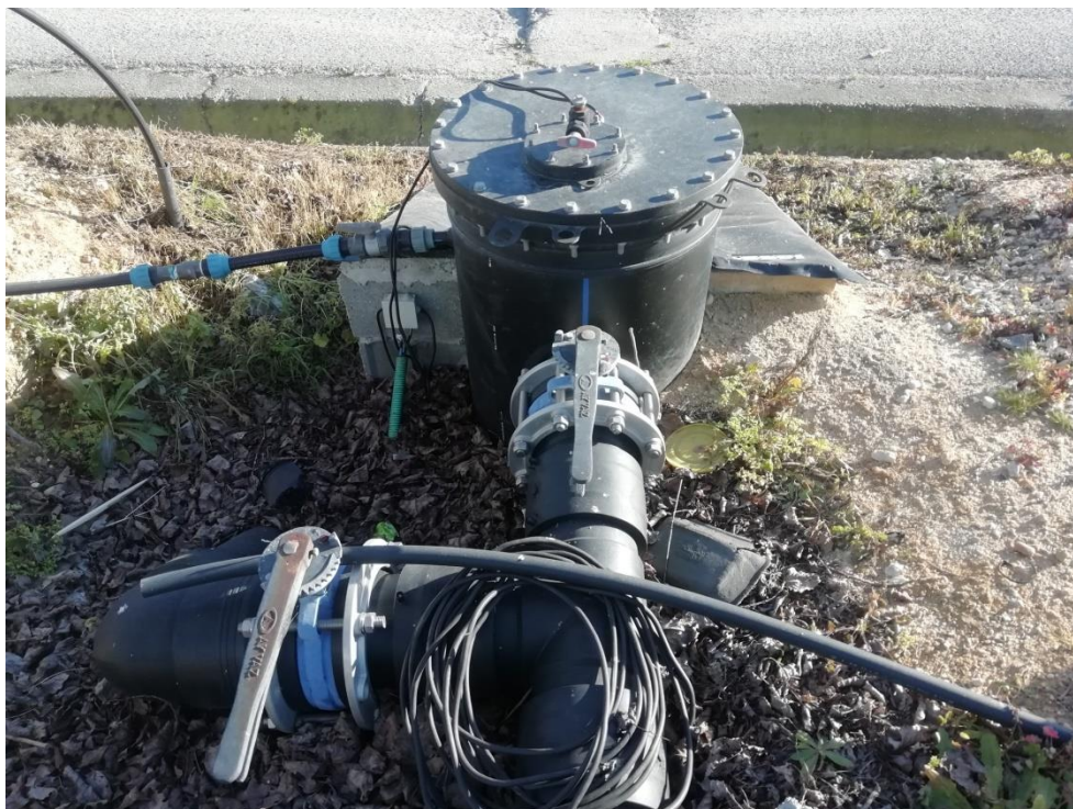
Poço de condensados
