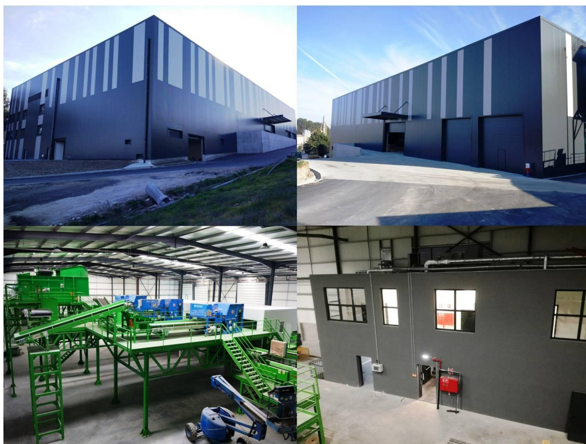
Figura 15 – Imagens da nova Unidade de Triagem de Lustosa
