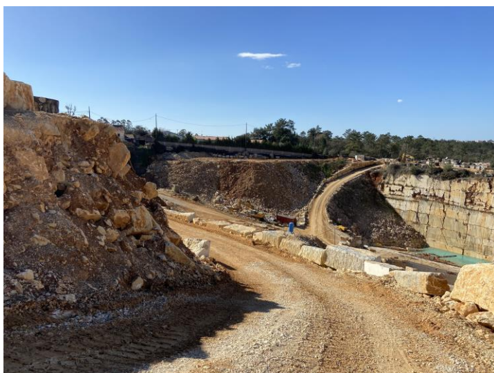
Foto 7 – Outra vista da rampa de acesso à área de ampliação que separa a cava, do lado direito, da área recuperada, do lado esquerdo.
