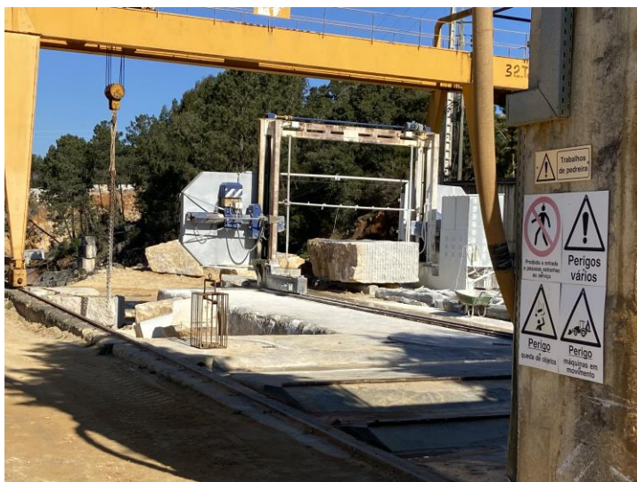
Foto 9 – Unidade industrial formada pelo pórtico, monofio e tanques de decantação.
