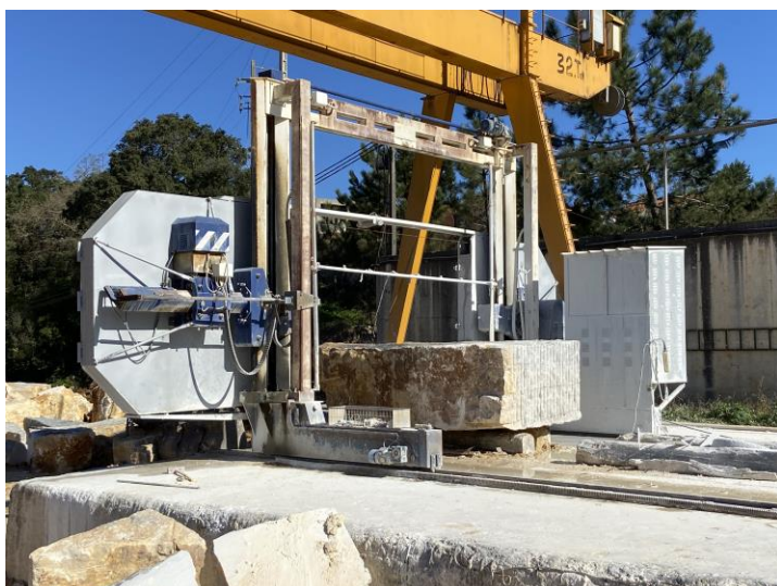
Foto 10 – Esquadriamento do bloco por ação de corte no monofio, por via húmida.
