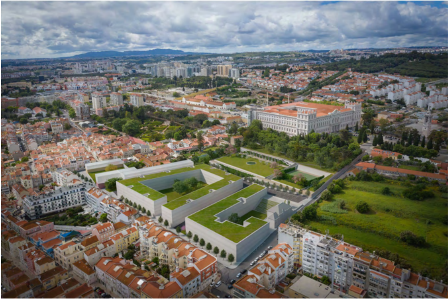
Vista aérea da intervenção | nascente-poente
