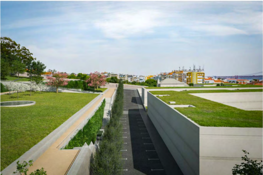
Travessa Nova | vista poente-nascente
