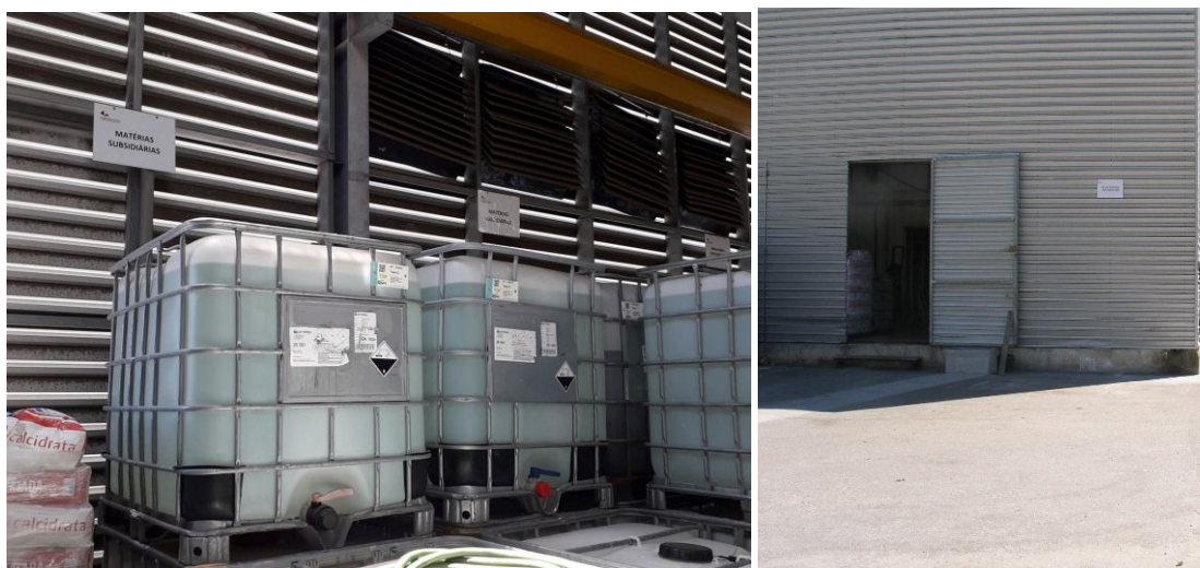
Figura 10. Armazém de produtos químicos.
