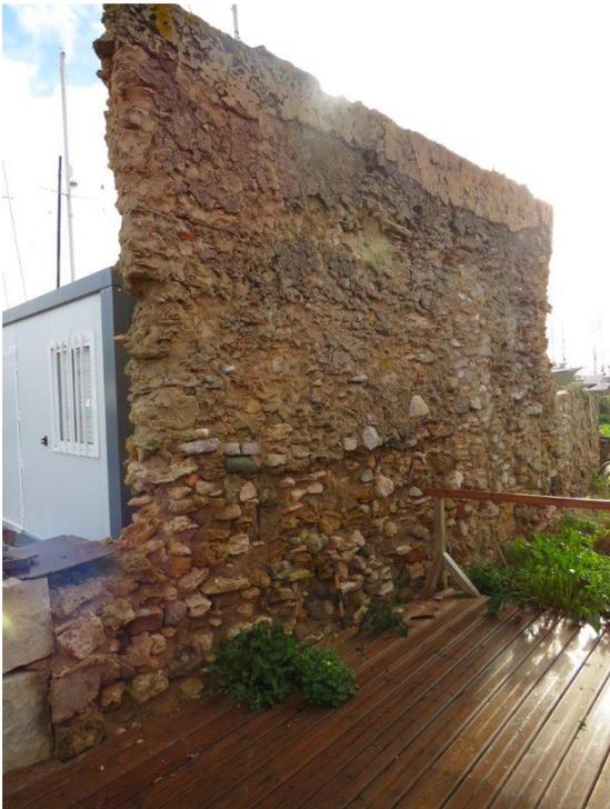
Figura 26 – Parede Oeste (parede original) do Moinho do Sobradinho com revestimento em cimento e ferro.
