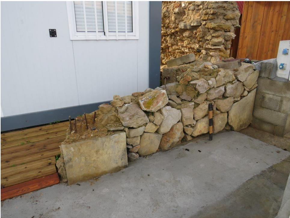
Figura 25 – Exemplo de um dos muros do Moinho do Sobradinho, reconstruído com pedra, cimento e ferro.
