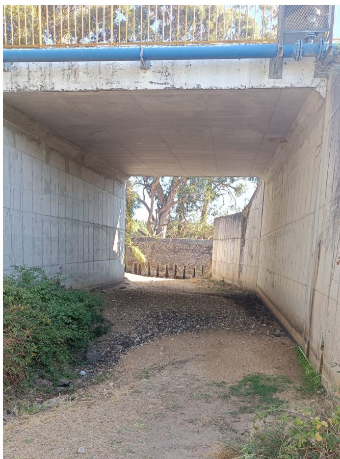
Ribeira da Maçussa no viaduto da EN366.
