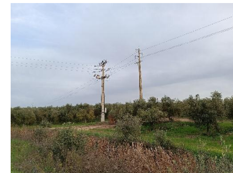
Figura 10 - Vista sobre a área de implantação da IPBB
