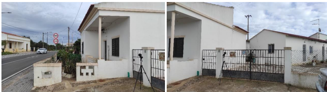
Figura 4 – Apontamento fotográfico pontos PR1
