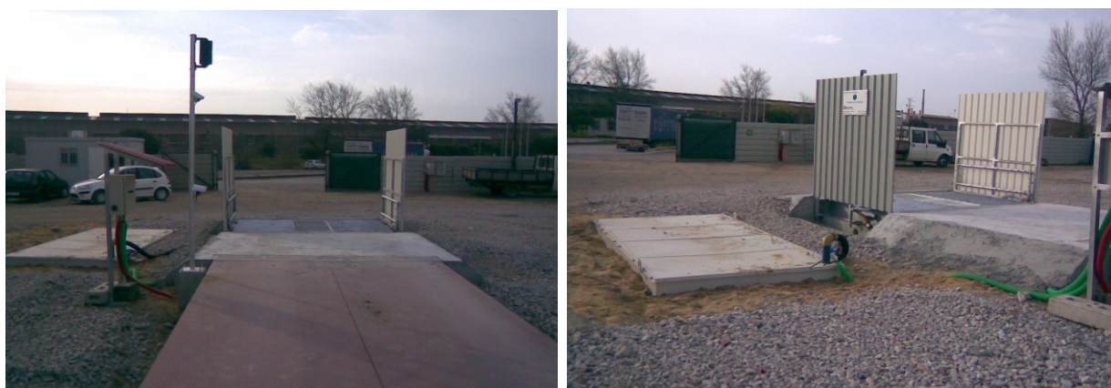
Figura 2 - Exemplo de sistema de lavagem de rodados
