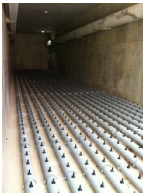
Figura 13 – Construção de piso de spigots.
