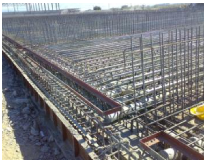
Figura 13 – Construção de piso de spigots.
