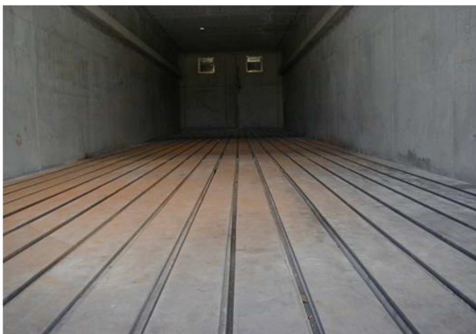
Figura 2 Vista interior do túnel.
