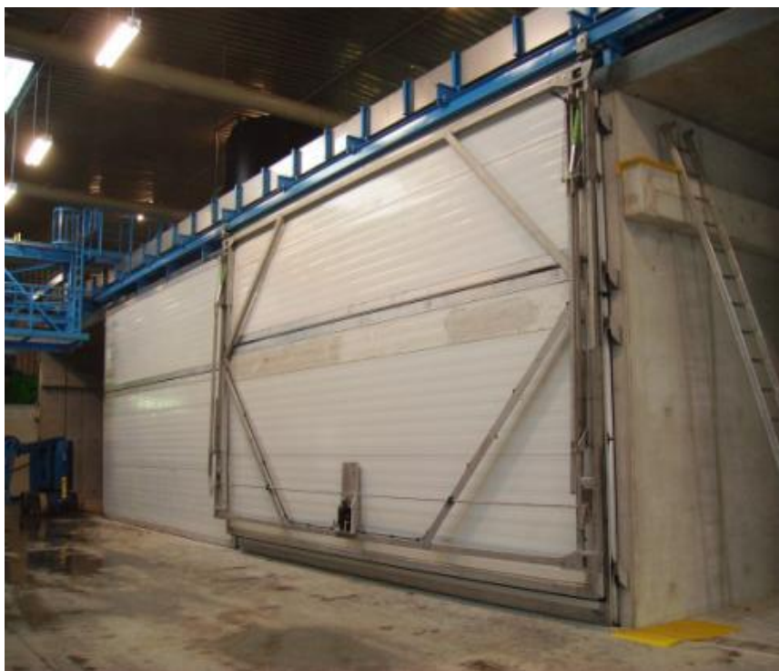
Figura 5 Porta do túnel com carro de translação.
