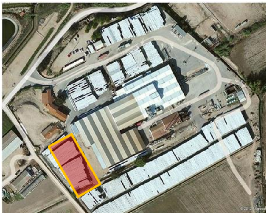
Figura 2.1 – Área Alvo de Intervenção [Construção de Edifício de Armazenagem de produto acabado – n.º 15]
