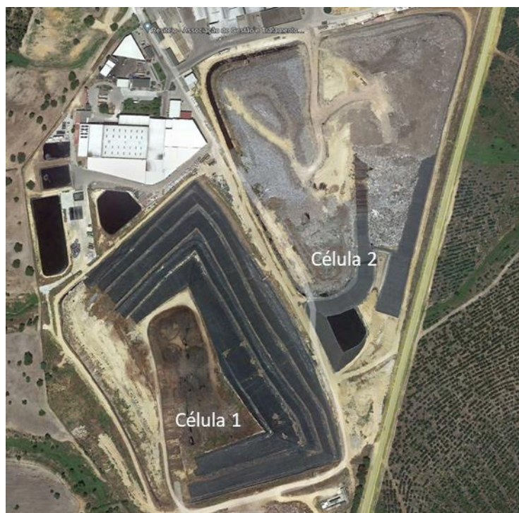
Fotografia 3-1 – Células de deposição de resíduos no aterro da RSTJ (junho 2021) (Fonte da imagem: Google Earth).
