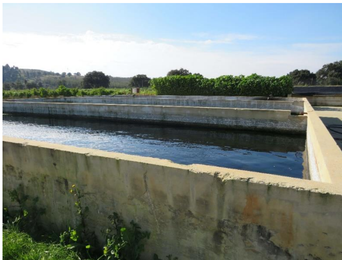
Fotografia 3-9 – Tanques de concentrado do aterro da RSTJ.
