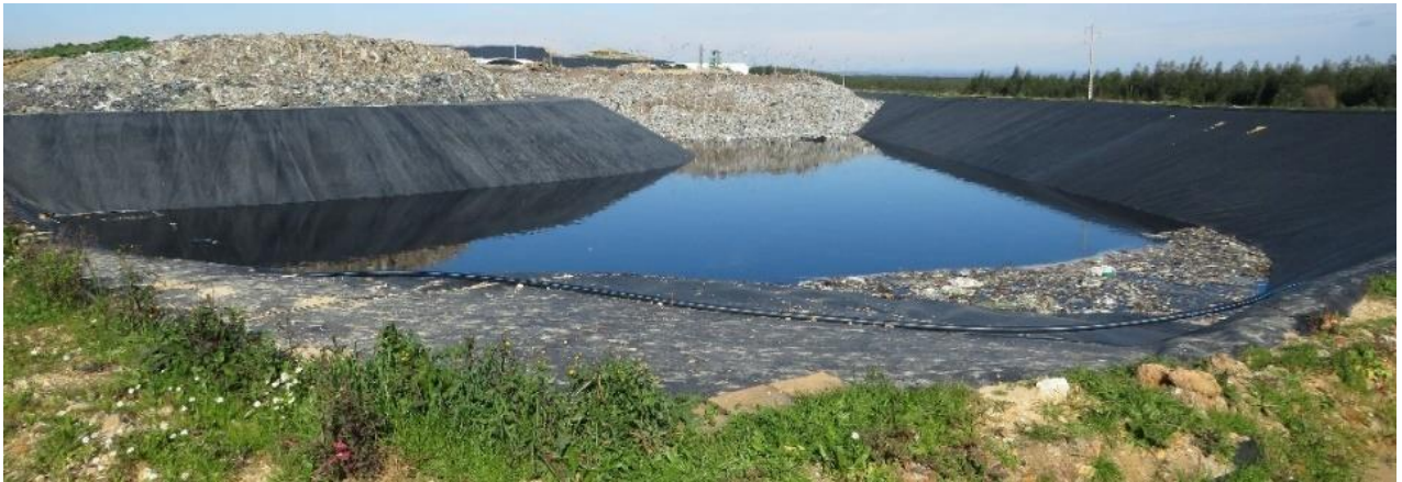
Fotografia 3-12 – Alvéolo 8 da Célula de deposição de resíduos 2 do aterro da RSTJ.
