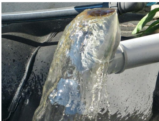
Fotografia 3-10 – Permeado resultante do sistema Osmose Inversa.
