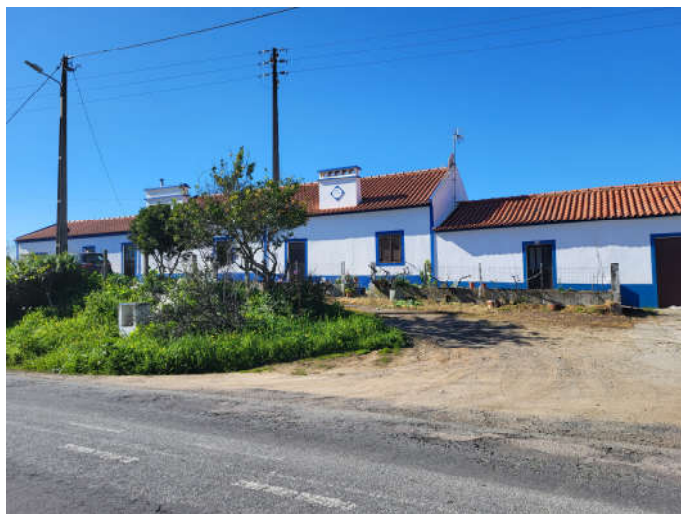
FOTO 21 – HABITAÇÃO E VEDAÇÃO CONTÍGUAS AO MURO M2 A CONSTRUIR
