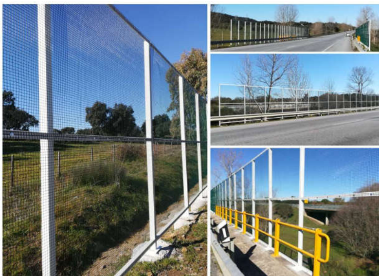
FOTO 1 – BARREIRAS IMPLEMENTADAS NA EN114, NO ÂMBITO DO PROJETO LIFE LINES, COM 3 M DE ALTURA (A PARTIR DA PLATAFORMA), CONSTITUÍDAS POR PRUMOS METÁLICOS DE SECÇÃO RETANGULAR RHS 80x60x3, COM TAMPAS PLÁSTICAS NO TOPO, AFASTADOS DE 2 M, QUE PERMITEM SUPORTAR UMA MALHA DE ARAME GALVANIZADO, SOLDADA E PLASTIFICADA A PVC/POLIÉSTER, COM DIÂMETRO DE 19 x 19 MM E DIÂMETRO DO ARAME DE 2 MM. OS PRUMOS SÃO ENCASTRADOS NO MACIÇO DE FUNDAÇÃO (IP, 2021)
