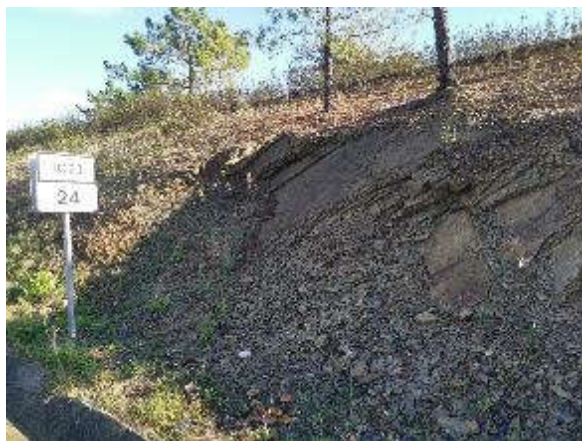
FOTO 4 – AFLORAMENTO DE XISTOS ARGILOSOS PERTENCENTES À FORMAÇÃO H_{Mi} , AO KM 28+880 (LD)
