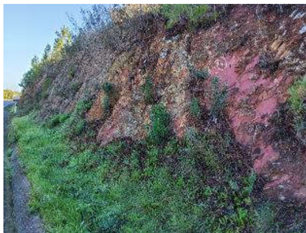
FOTO 2 – AFLORAMENTO DE SEDIMENTOS VULCANOGÉNICOS FINOS PERTENCENTES À FORMAÇÃO CVSMH, AO KM 42+460 (LD)
