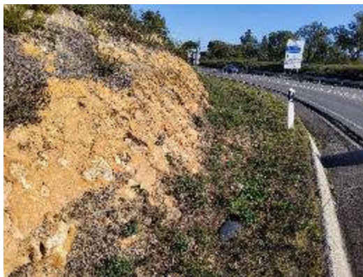
FOTO 2 – AFLORAMENTO DE ARENITOS PERTENCENTES À FORMAÇÃO PU AO KM 43+850 (LE)
