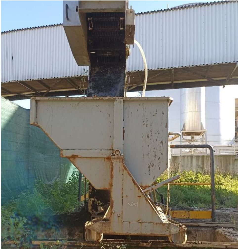
Figura 20 – Grade mecânica em operação
