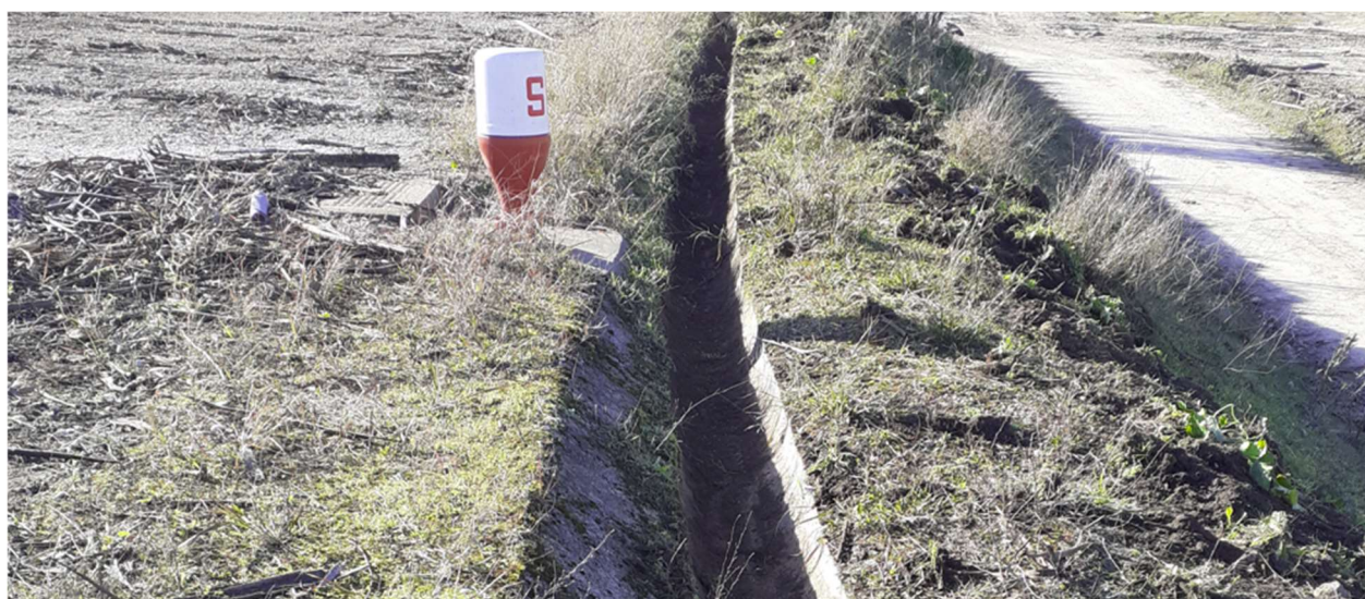
Figura 15 – Caleira de drenagem sector S7
