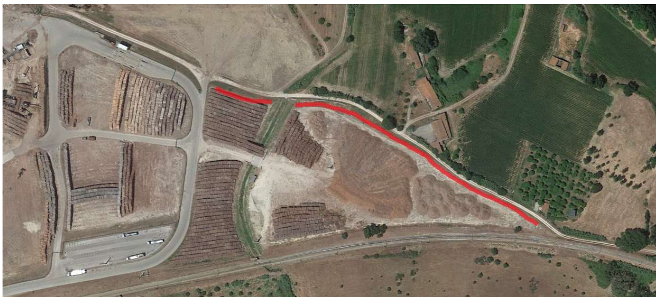
Figura 17 – implantação da faixa de retenção de matéria orgânica
