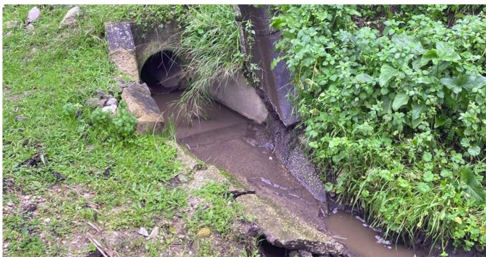
Figura 13 – Boca de saída do colector proveniente da sub-bacia SB4
