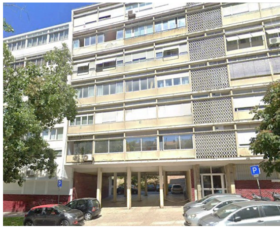
(a) Vista da passagem inferior sob o edifício n.º 59 da Av. Infante Santo
