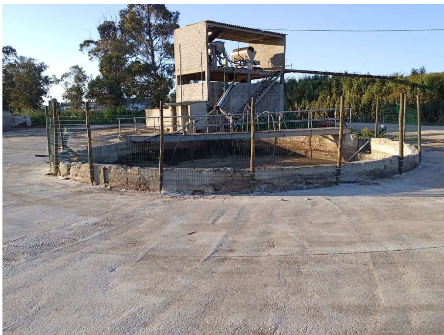
Foto 2 - Poço de recepção
