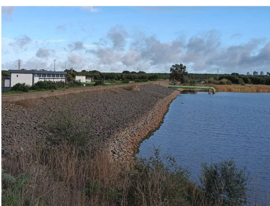
8 – Estação elevatória junto à Barragem do Monte do Marmelo
