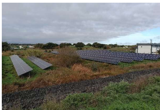
9 –UPAC associada à Estação Elevatória da Barragem
