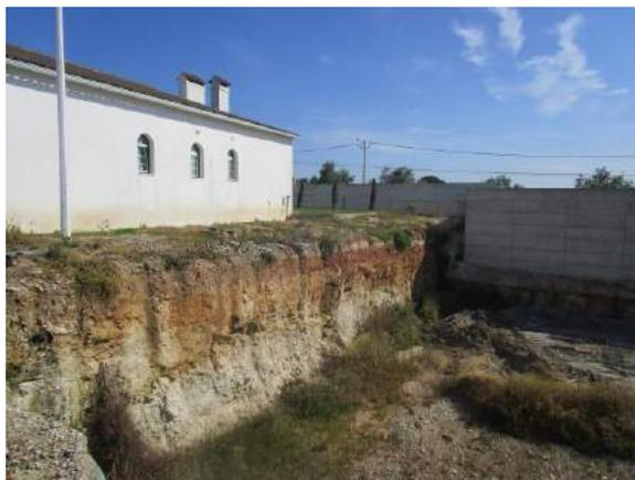
**Figura 77 – Vista geral do corte estratigráfico no local onde vai ser erguido o novo terreiro**
