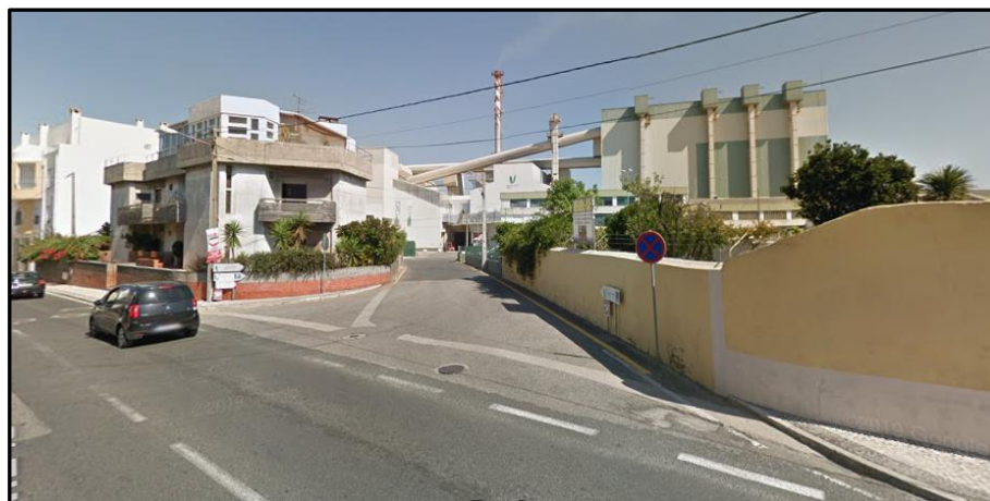
Fig. 5.43 - Vista da GALLOVIDRO a partir da via de comunicação - M242-1
