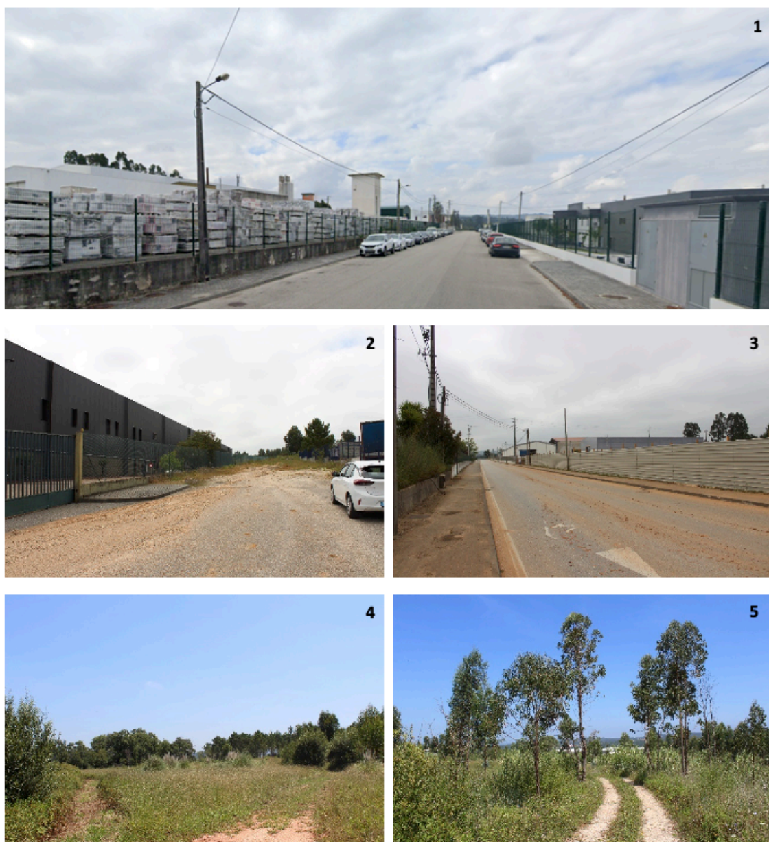
Imagens da UP1 - Unidade Industrial de Condeixa-a-Nova, da área industrial existente (imagem 1, 2 e 3) e da área a ampliar (imagem 4 e 5)
